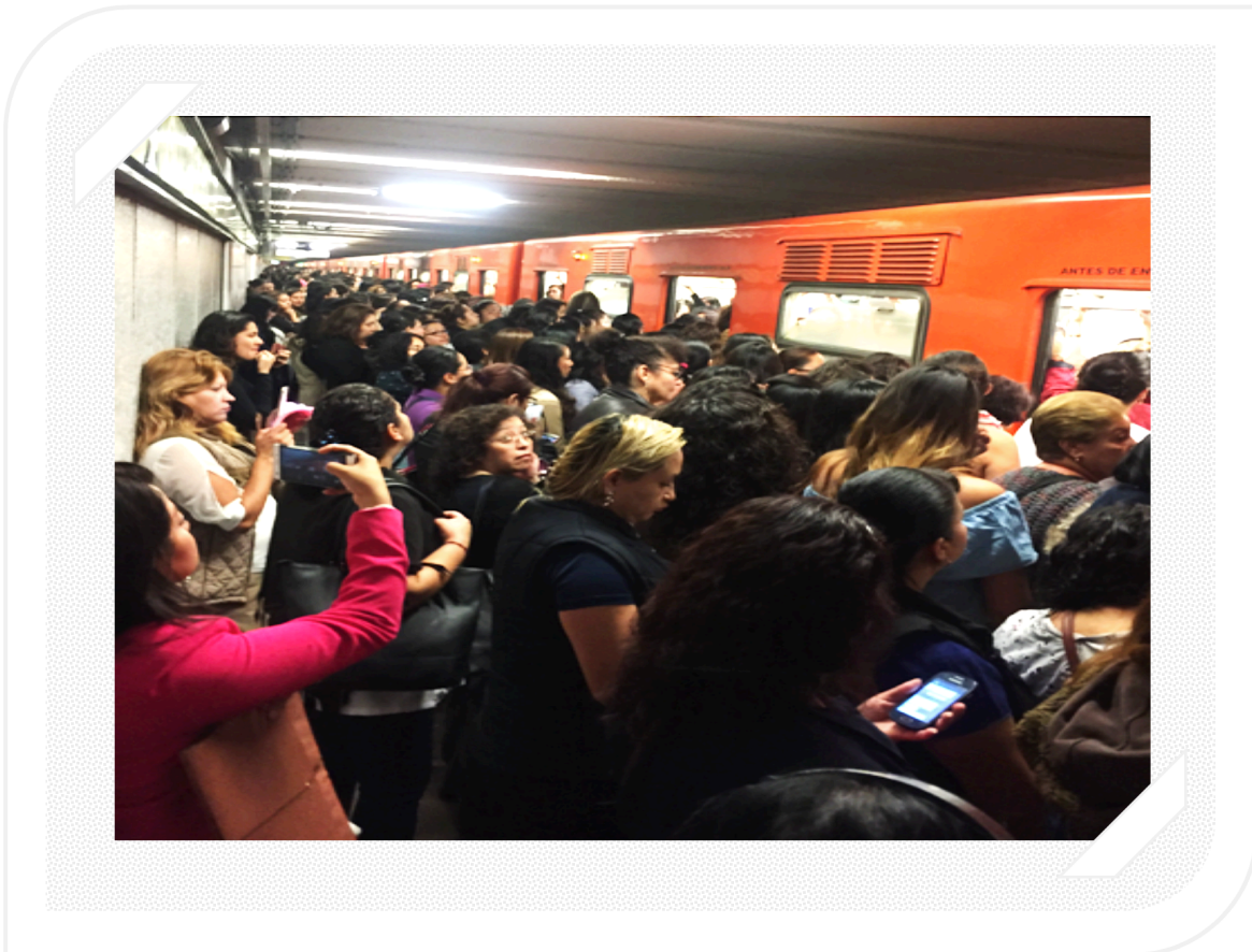
Ilustración 48 Estación Guerrero_Congestión de usuarios en el andén. Fuente: Visita técnica (2018).
