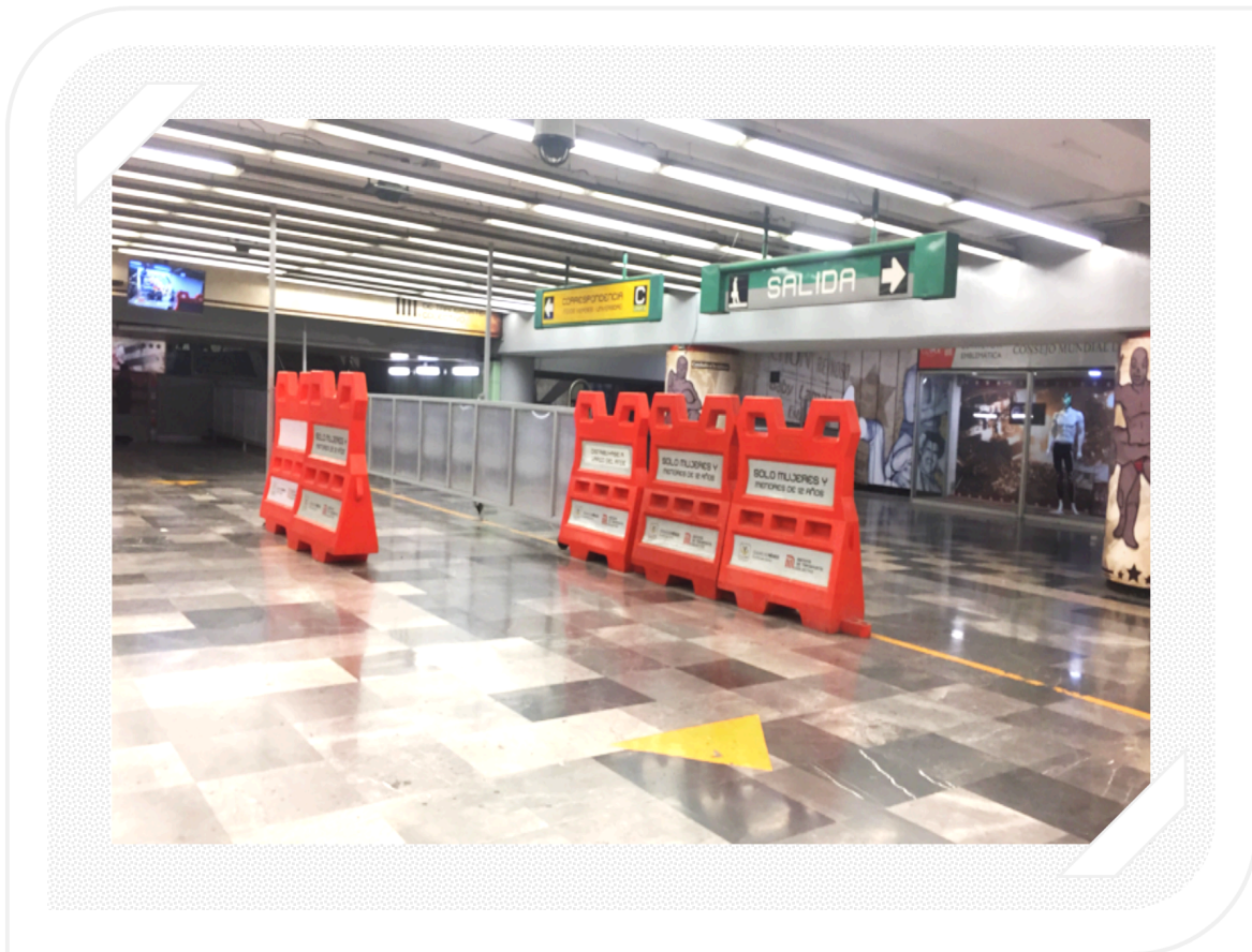
Ilustración 43 Estación Guerrero_Carriles delimitados temporalmente. Fuente: Visita técnica (2018).
