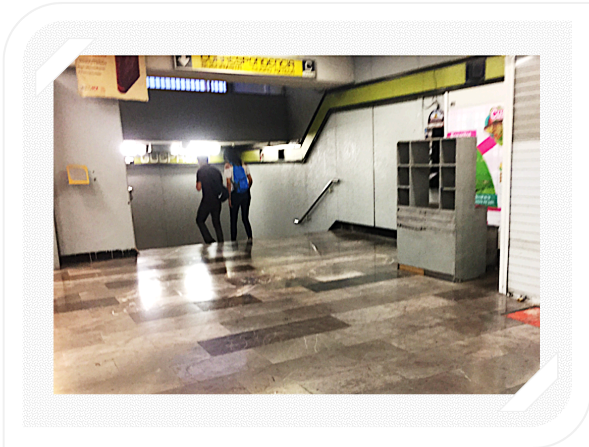
Ilustración 41 Estación Guerrero_Pasillo de conexión entre línea 3 y línea B. Fuente: Visita técnica (2018).
