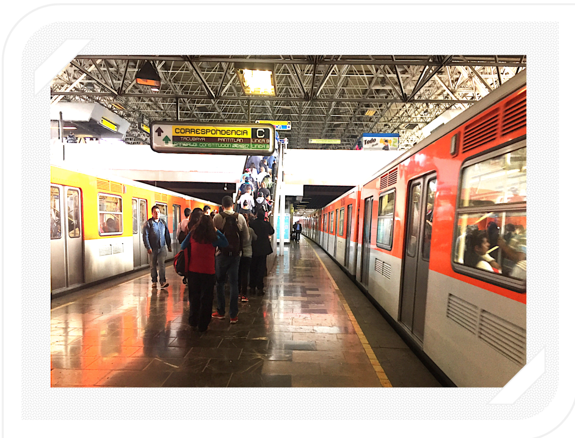
Ilustración 18 Estación Chabacano_Andén de descenso y escaleras de salida.
