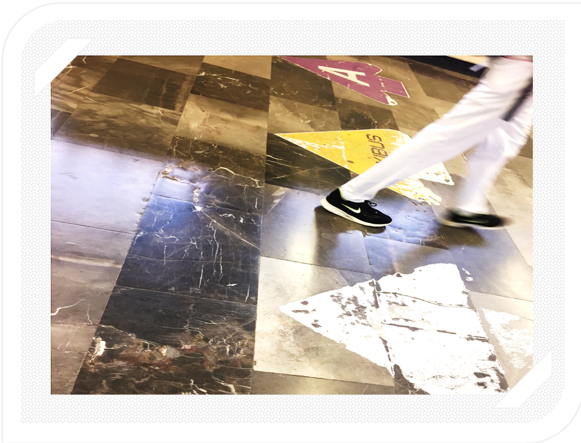
Ilustración 7 Estación Pantitlán_Señalización en piso. Fuente: Visita técnica (2018).
