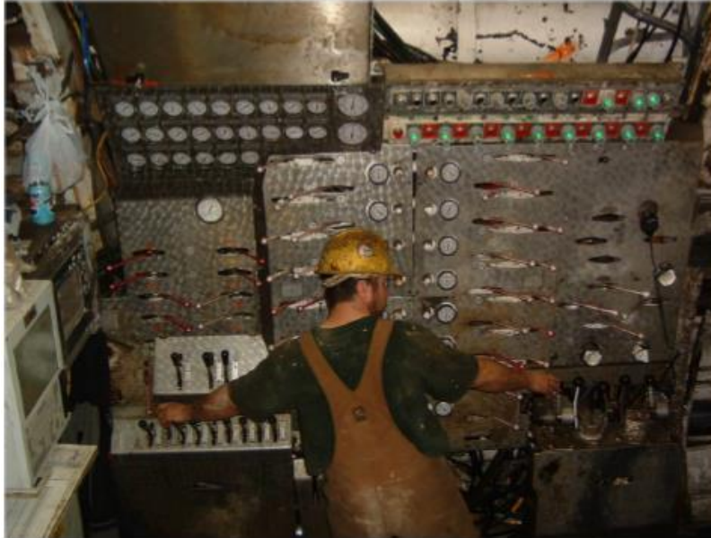
Figura 1.7 Operación de una TBM en los años 90's. (www.tunnelsoft.com).
