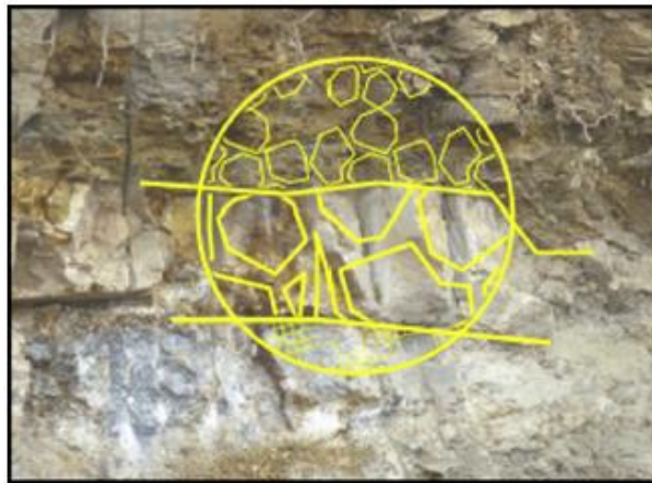
Figura 2.3 Frente de excavación mixto en una Interfaz roca-suelo, Tóth et al. (2013).
