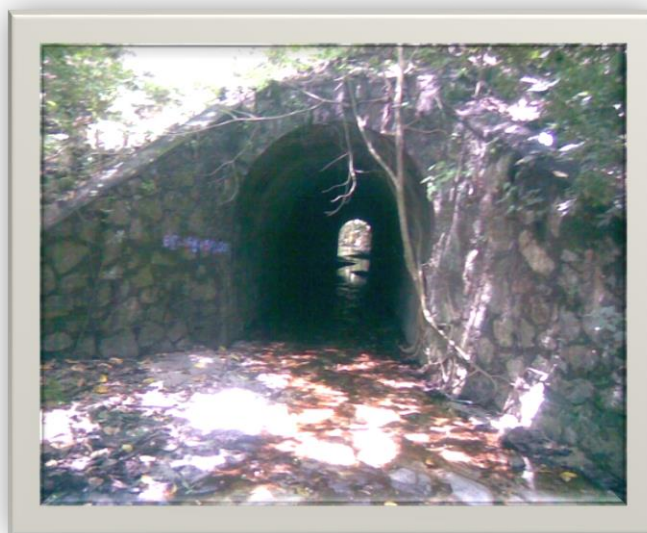
Alcantarilla Tipo Bóveda
