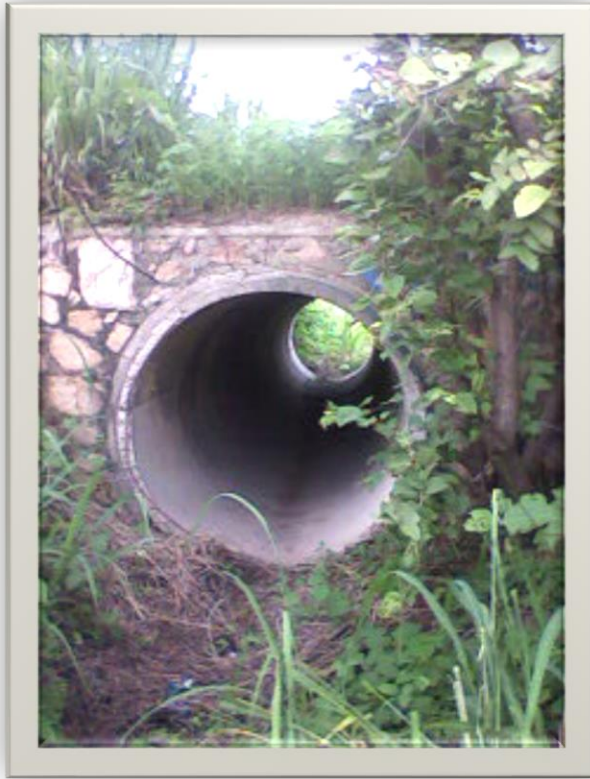
Alcantarilla de Tubo de Concreto
