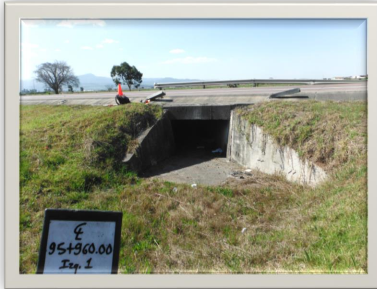
Alcantarilla Tipo Losa
