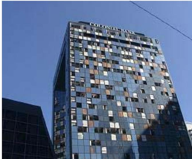
**Figura 1.4 Daños en los cristales debido a los efectos del huracán Wilma (2005),
