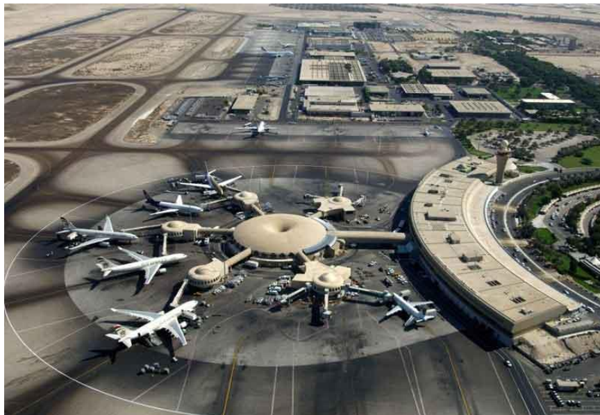
Figura 2.2 Edificio Terminal del AUH [7]
