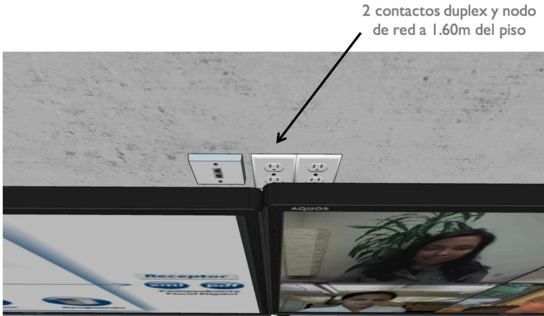
Figura 3.14 Contactos eléctricos y nodo de red
