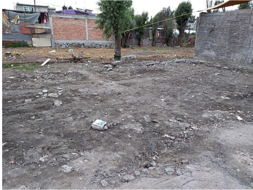
• Figura 25. Predio donde se derrumbó una casa.
