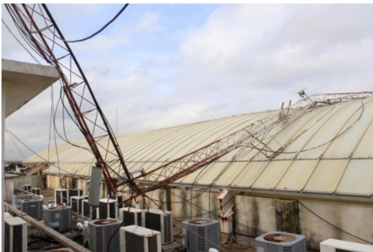
Figura 1.5. Torre de telecomunicaciones en Coatzacoalcos, Veracruz.
