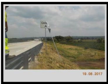
Figura 9: Reparación de señalamiento vertical bajo. Antes, durante la actividad, después de realizada la actividad. (Actividad realizada en Libramiento de Guadalajara, km 7+525, Agosto 2017)
