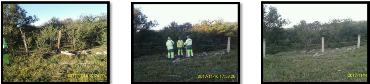
Figura 6: Antes del cercado, durante la actividad, después de la actividad. (Actividad realizada en Autopista La Venta – Chamapa, km 55+000, cuerpo A. Noviembre 2017)
