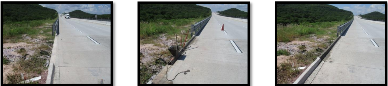
Figura 7: Reposición de bordillos con caucho. Antes, durante la actividad, después de la reposición. (Actividad realizada en Libramiento Mazatlán, km 253+500, cuerpo B, Septiembre 2017)
