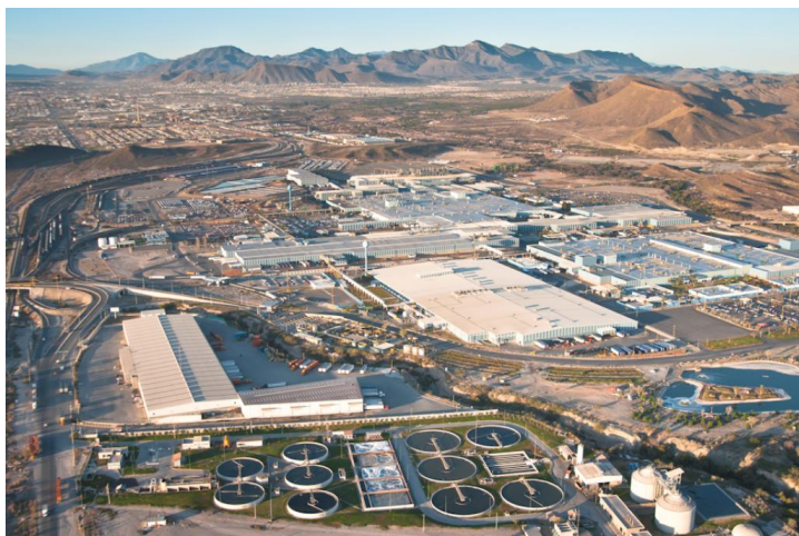
Figura 1: “Planta de tratamiento de agua residual (PTAR) de Saltillo, Coahuila”
