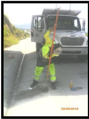
Figura 8: Reposición de indicadores de alineamiento. Antes, durante la actividad, después de realizada la actividad. (Actividad realizada en Libramiento de Guadalajara, km 25+000 a 21+000, cuerpo B, Agosto 2017)
