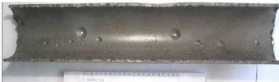
Figura 1.8 Corrosión por picadura en una línea de producción (Pan American Energy, 2007).
