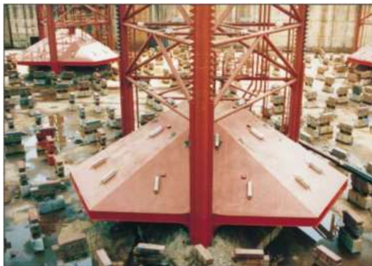
Figura 1.6 Ánodos sacrificio en la pierna y el tanque de carga de una plataforma (Brondel, 1994).
