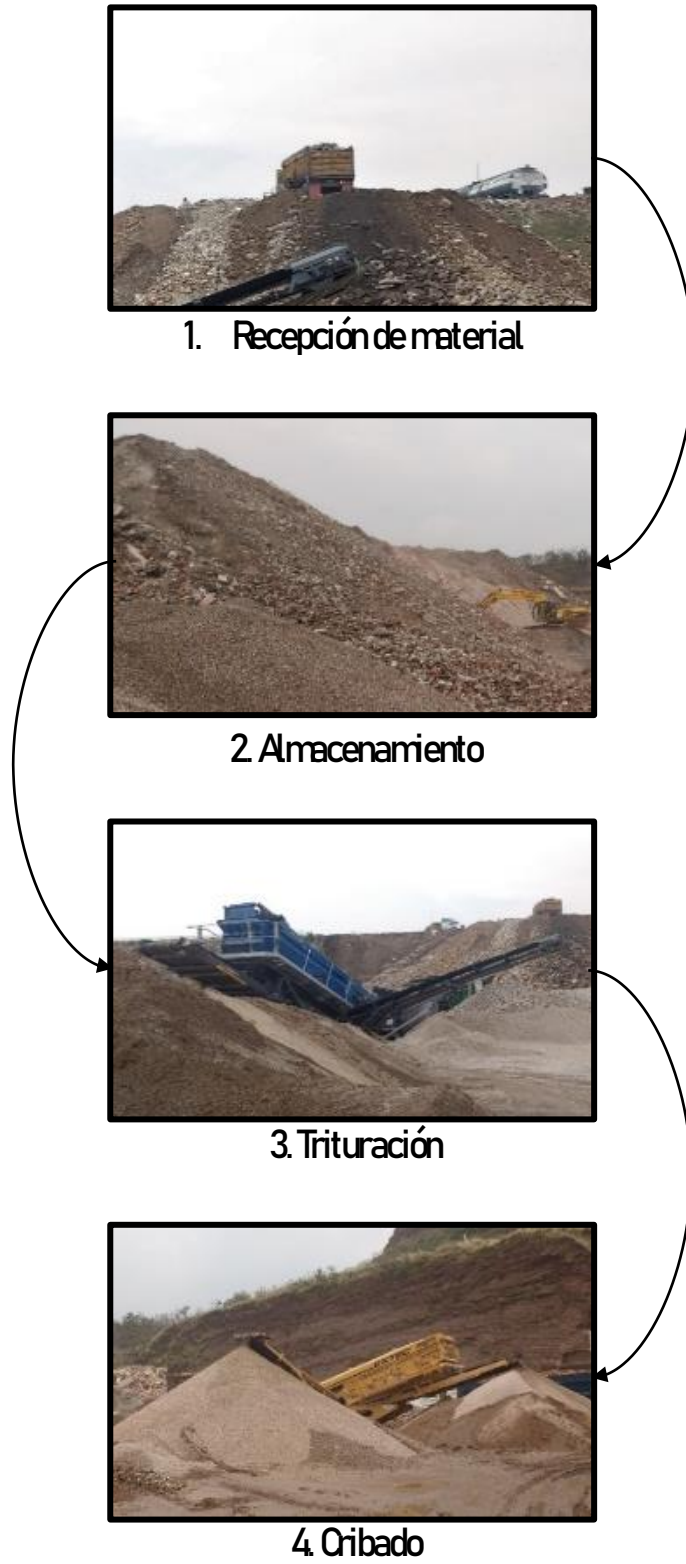
Figura 1.7 Proceso de tratamiento de los residuos de construcción y demolición en la planta de "Concretos reciclados" [49].
