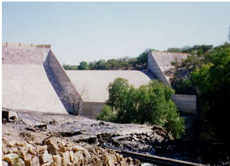
Figura 2.8 Vertedor con caída en rápida de la Presa El Niágara, Ags., CNA.
