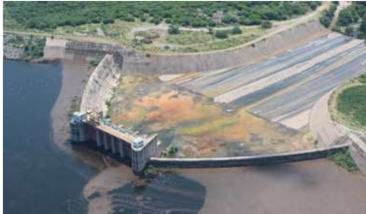
Figura 2.12 Vertedor en abanico de la Presa Mocúzari, Son., CNA.
