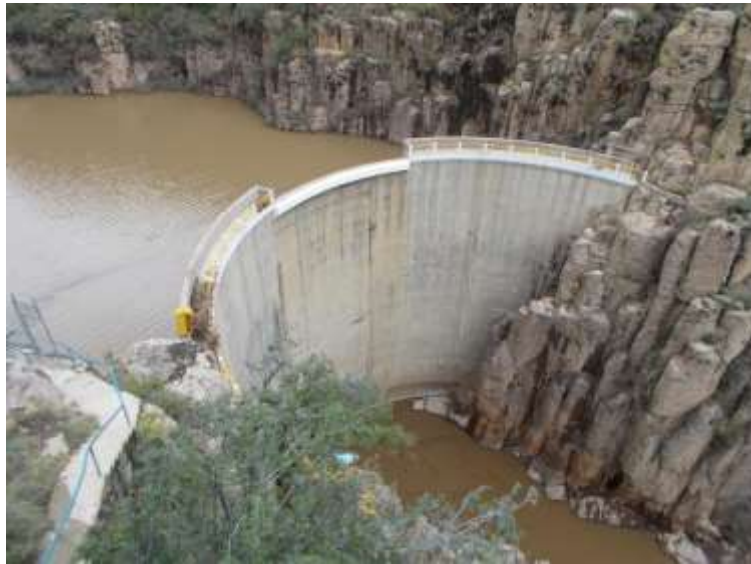
Figura 2.4 Vertedor de caída libre de la Presa Derivadora Pabellón, Ags., CNA.
