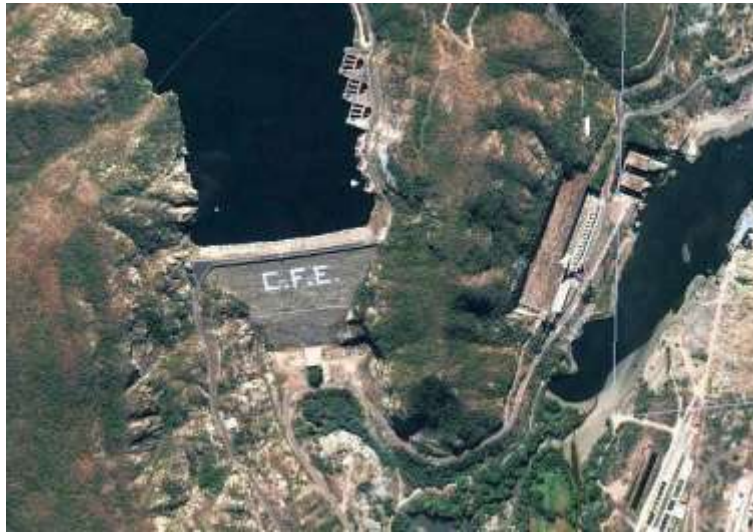
Figura 2.6 Túneles vertedores de la Presa Infiernillo, Mich., CNA.
