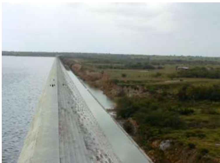
Figura 1.3 Presa las Blancas, Tamaulipas, CNA.
