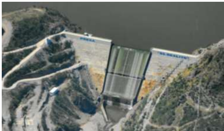
Figura 3.8 Vista de la presa “El Realito”, Estado de Guanajuato, CNA.
