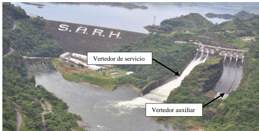
Figura 2.3 Vertedor de servicio y auxiliar de la presa Netzahualcóyotl (Malpasos), Chiapas, CNA.
