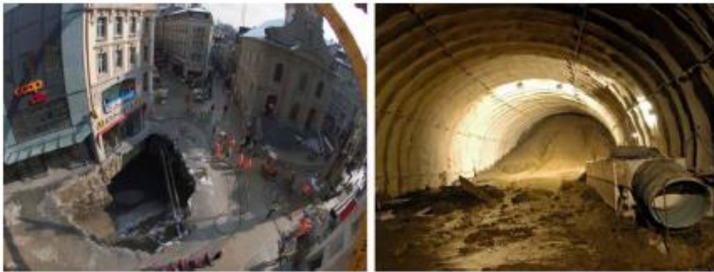
Figura 24. Jiménez, A (2016). Colapso del metro Lausanne, Suiza en 2005. Recuperado de Sistemas de Presostenimiento para Túneles en Terreno Difíciles.
