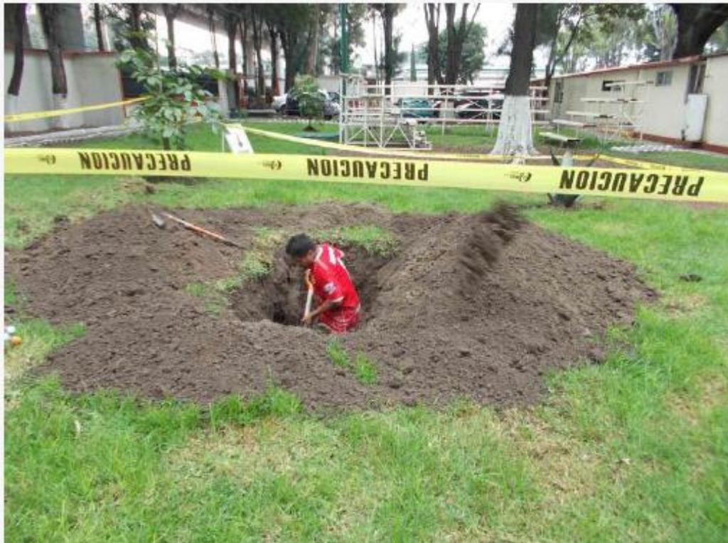
Figura A. 12 Pozo a Cielo Abierto.
