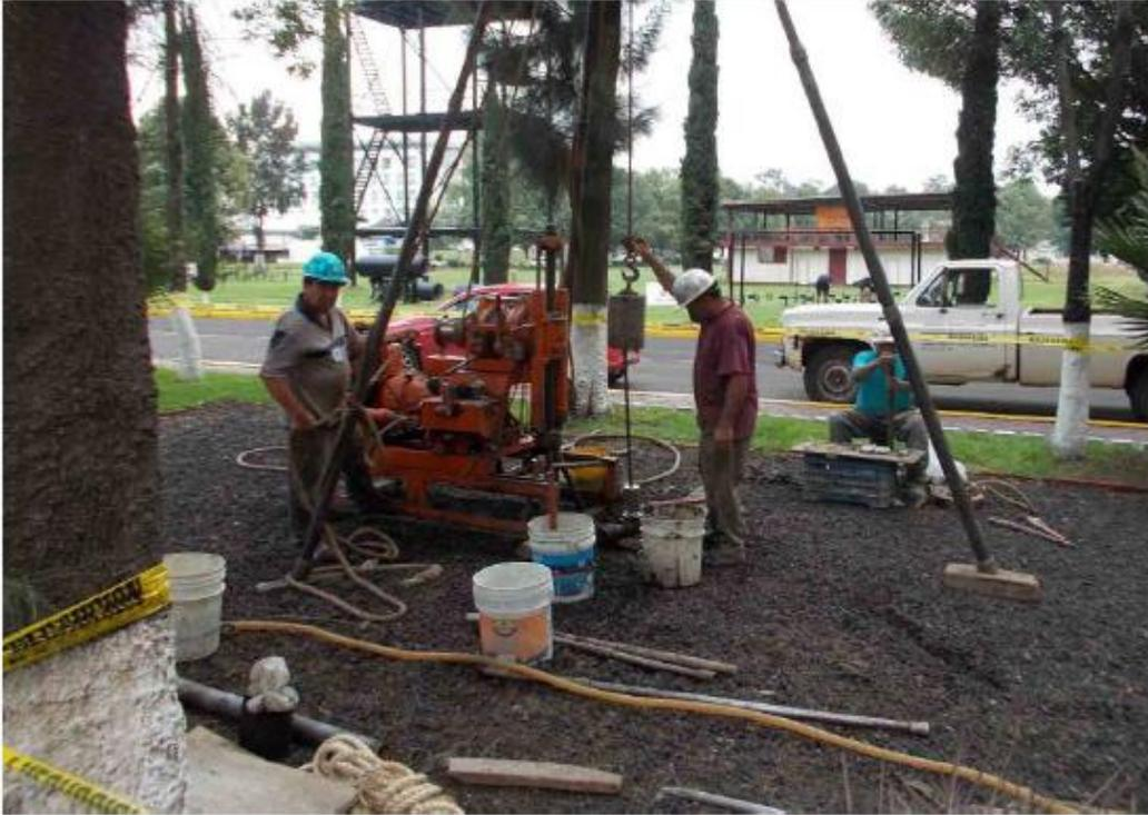
Figura A. 11 Sondeo de Penetración Estándar.
