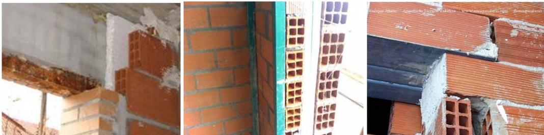
Figura 10. Ejemplos de piezas de mampostería no permitidas por las NTCM 2017
