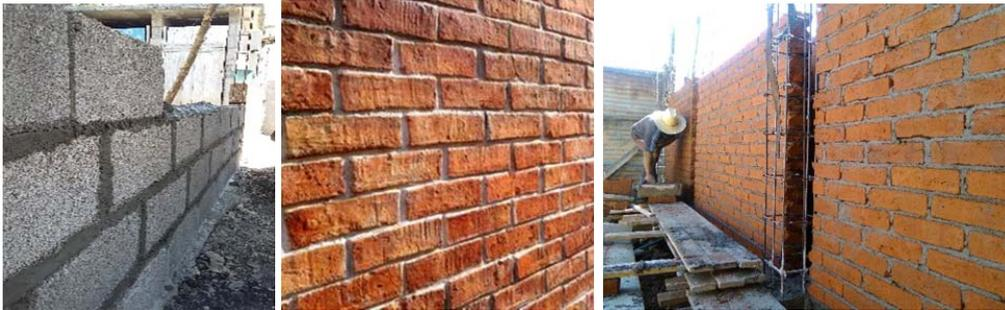
Figura 17. Fotografías con ejemplos de muros de mampostería con piezas acomodadas de forma cuatrapeada
