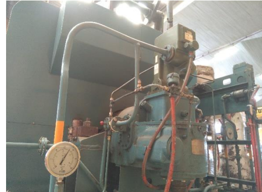
Figura 10. Amplificadores hidráulicos para control de turbina y extracción
