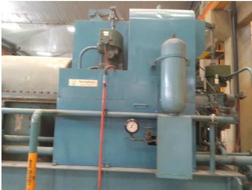
Figura 10. Amplificadores hidráulicos para control de turbina y extracción
