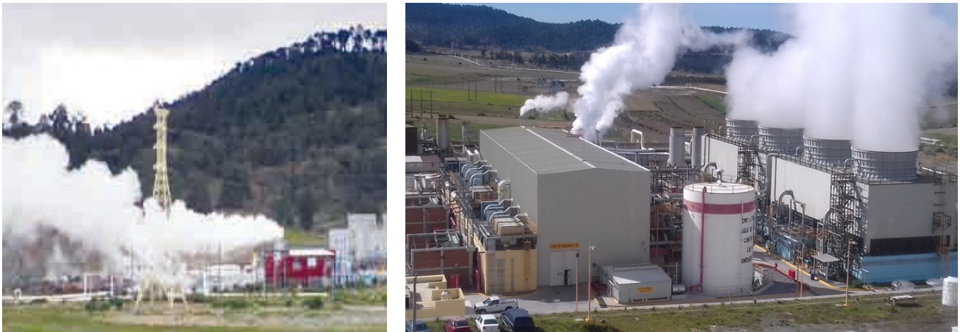
Figura 3.- Central geotermoeléctrica Humeros. Unidad a boca de pozo de 5MW (Izquierda) y unidad con condensador de 26.5 MW (Derecha).
