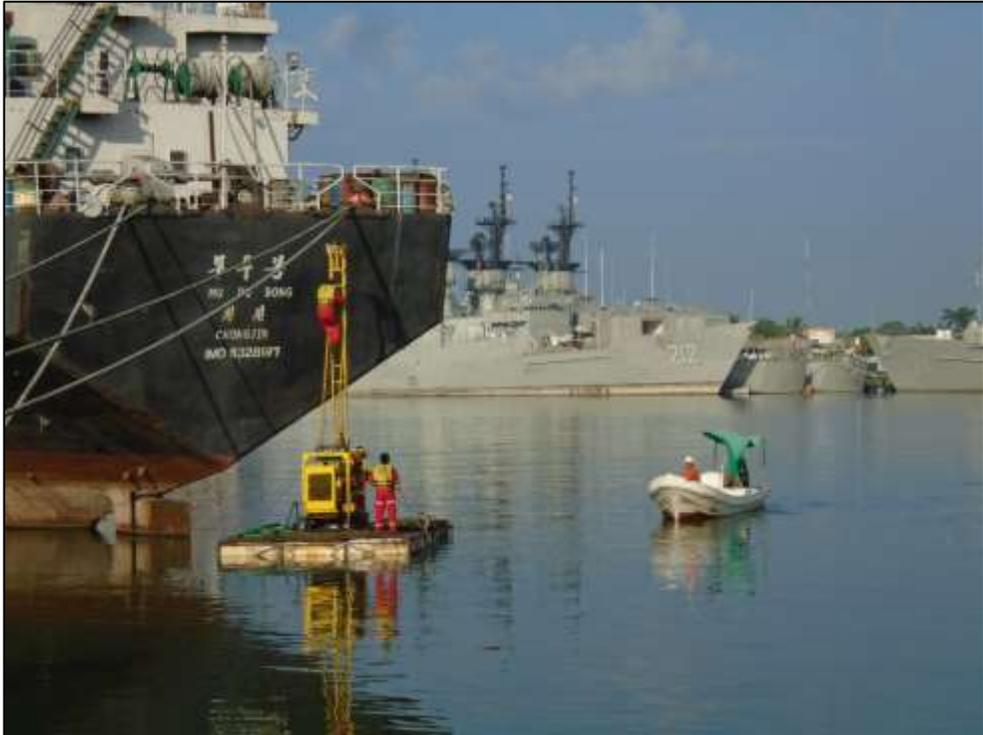
FIG.36 Equipo de perforación en balsa remolcada con ayuda de una lancha motorizada.
