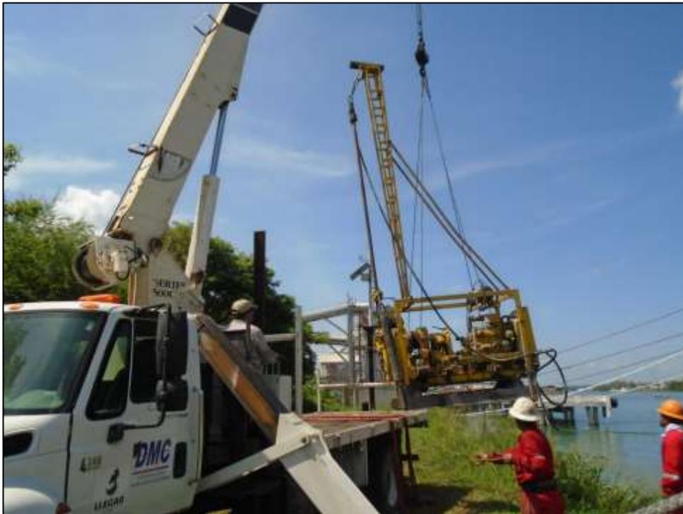
FIG.34 Botado de Equipo de Perforación "Longyear 34"
