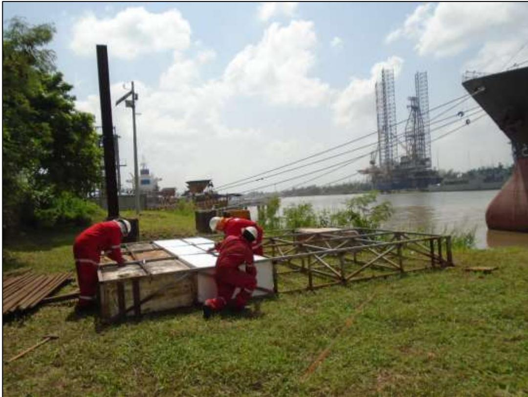
FIG.32 Habilitación de Balsa (chalan) para los trabajos de exploración en agua.
