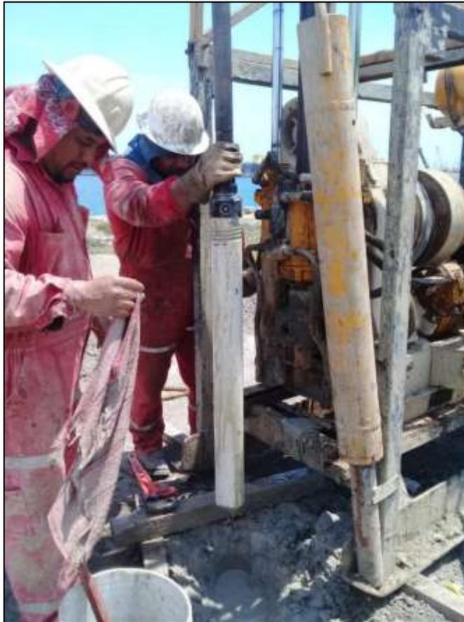
FIG.21 Muestreo con Tubo Shelby o pared delgada de 4". Puerto de Altamira, Tamps.
