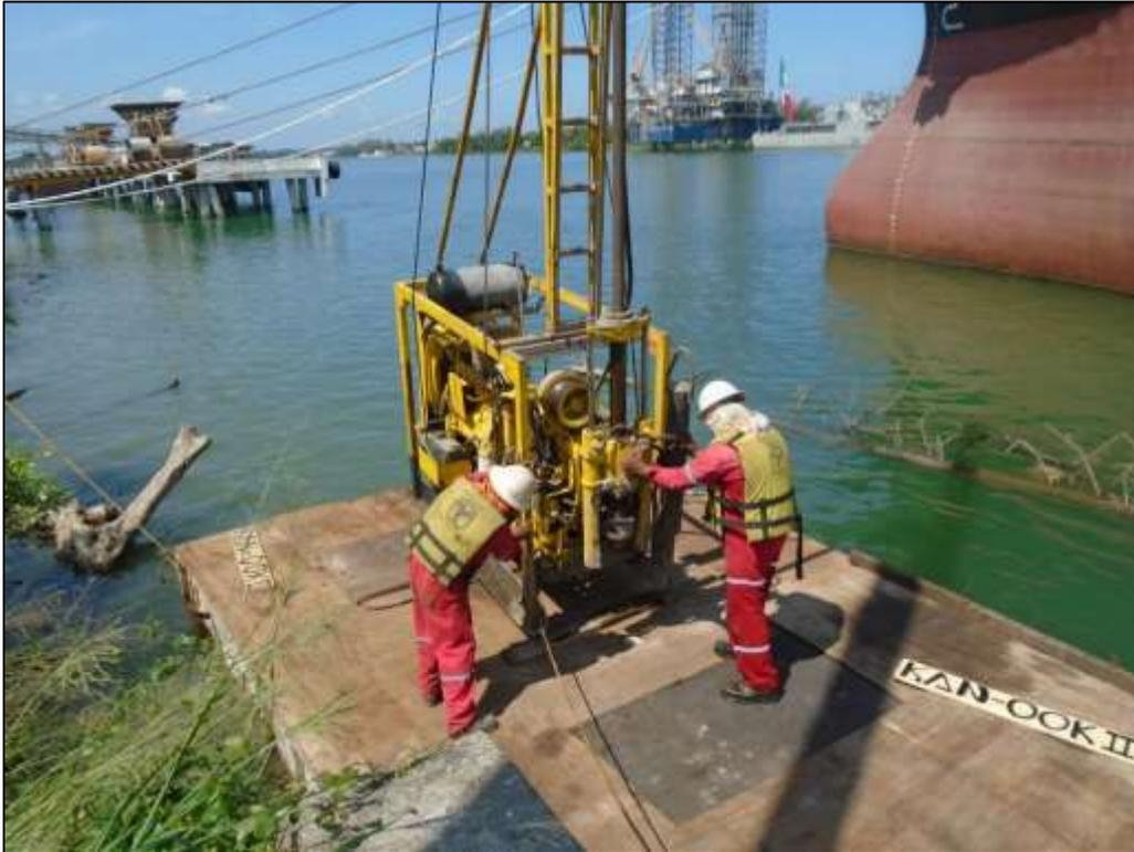
FIG.35 Colocación de Equipo de Perforación en Balsa (chalan)
