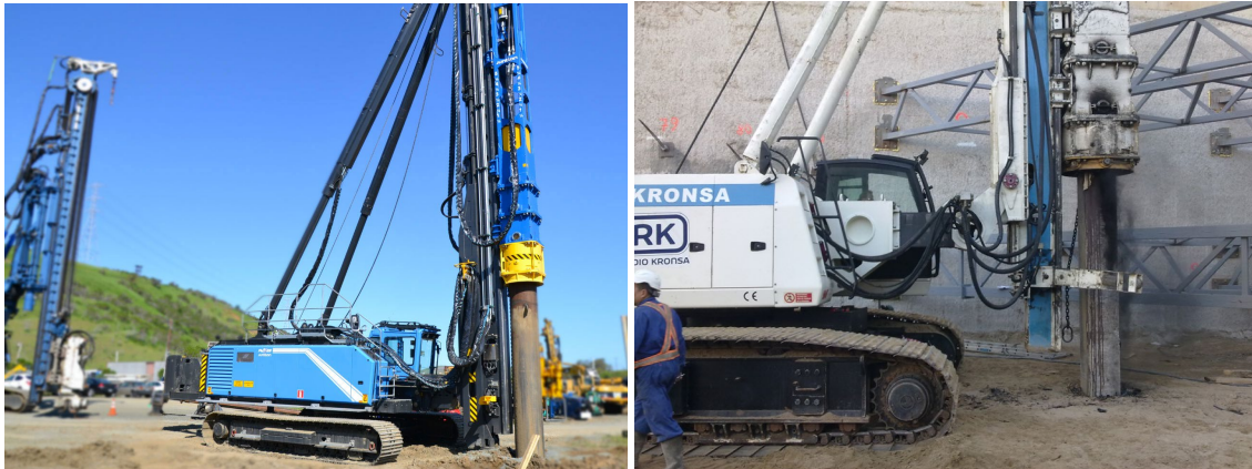
Figura I.6 Hincado de pilotes mediante impacto y vibrado
