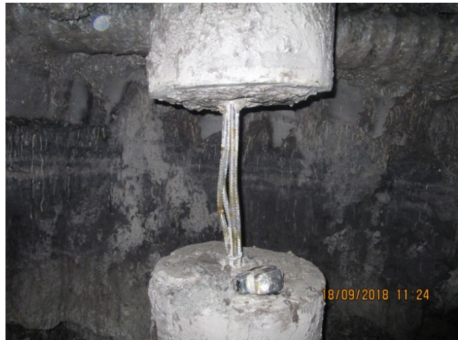
Figura I.7 Pilotes tipo mega
