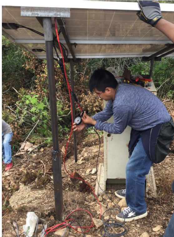
Figura 76. Colocación de la cinta de aislar Recuperado de: Visita técnica Agosto, 2017.
