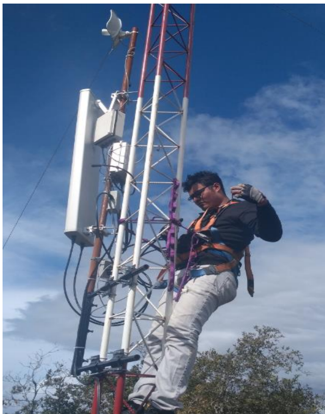
Figura 81. Montaje de la antena sectorial Recuperado de: Visita técnica Noviembre, 2017.
