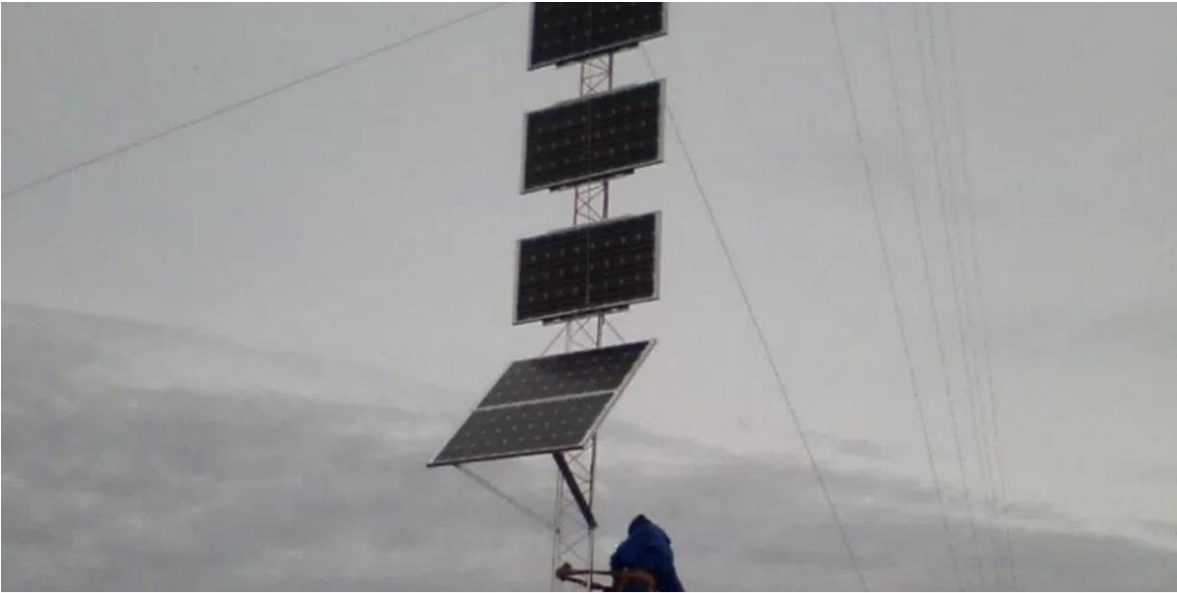
Figura 49. Instalación del sistema fotovoltaico en Santa Fe.
