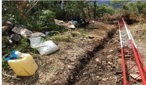
Figura 67. Visita técnica. Herramientas y torre. (2017) Recuperado de: Visita de técnica Agosto, 2017.
