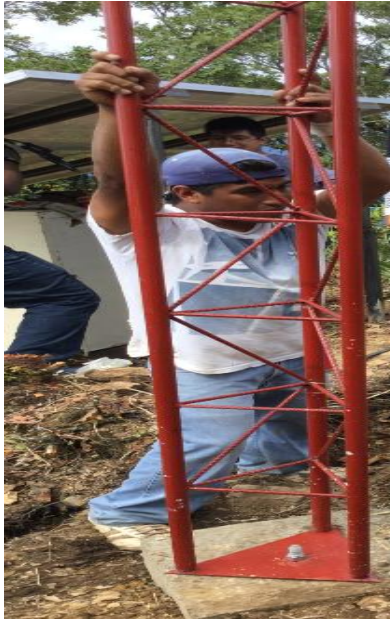
Figura 65. Montaje de la torre de comunicación. Recuperado de: Visita técnica Agosto, 2017.
