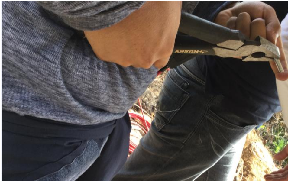
Figura 73. Comprimiendo la terminal para el cable. Recuperado de: Visita técnica Agosto, 2017
