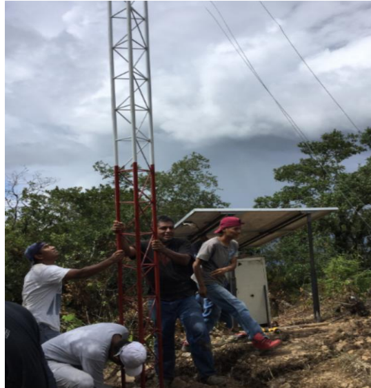
Figura 70. Colocación de la Torre. Recuperado de: Visita técnica Agosto, 2017.
