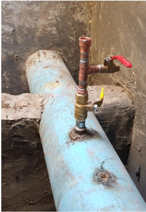
Ilustración 16. Hidrotoma instalada para sensor integrado (izquierda) y sensor de presión externo (derecha).
