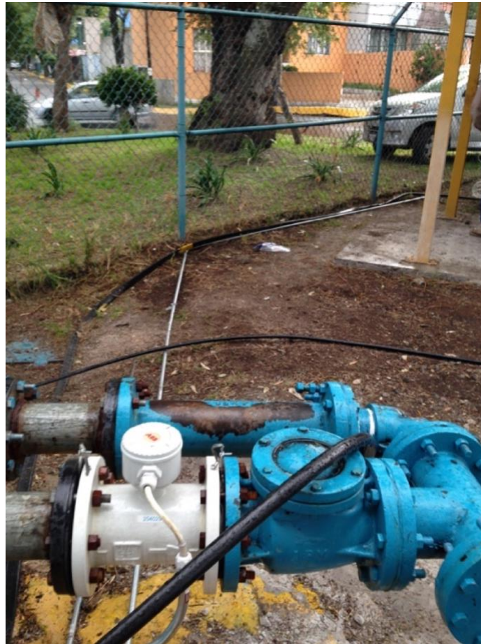
Ilustración 18. Macromedidor instalado.
