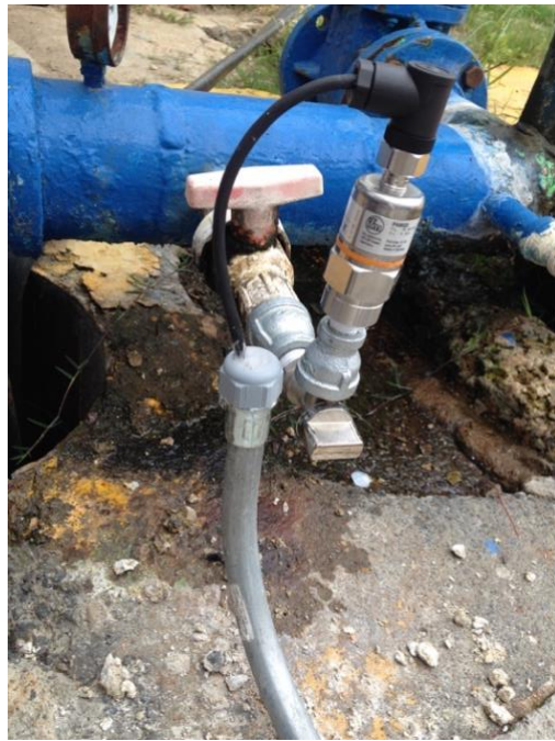
Ilustración 16. Hidrotoma instalada para sensor integrado (izquierda) y sensor de presión externo (derecha).
