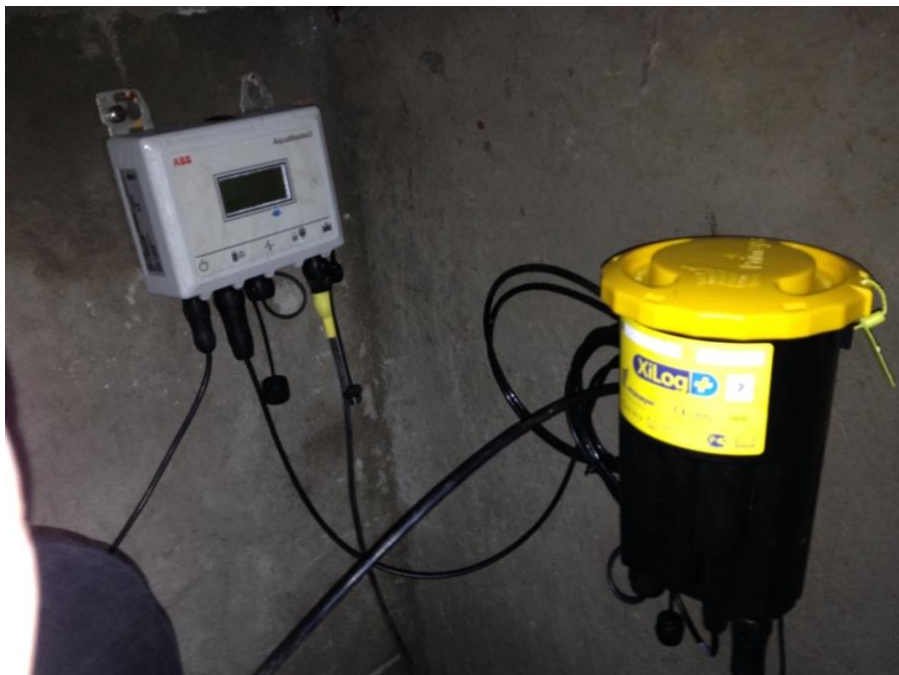
Ilustración 21. Ejemplo de medidor con alimentación eléctrica directa, 24V.
