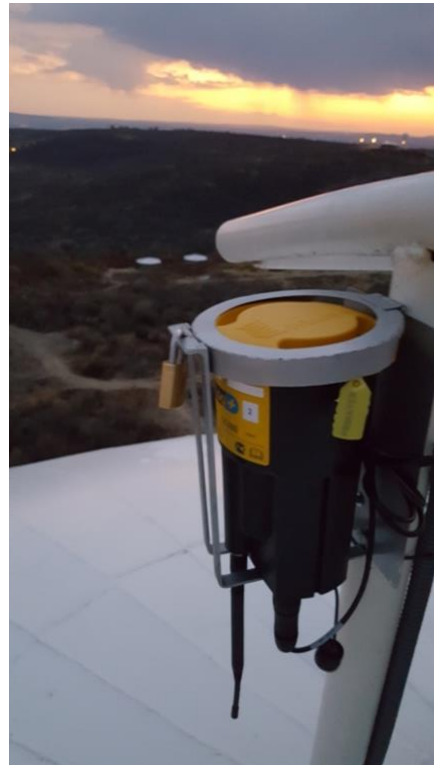
Ilustración 24. instalación del sensor de nivel en el tanque (izquierda) e instalación del datalogger (derecha).
