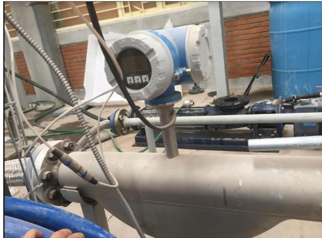
3.7 Medidor de flujo másico para fase líquida por efecto Coriolis
