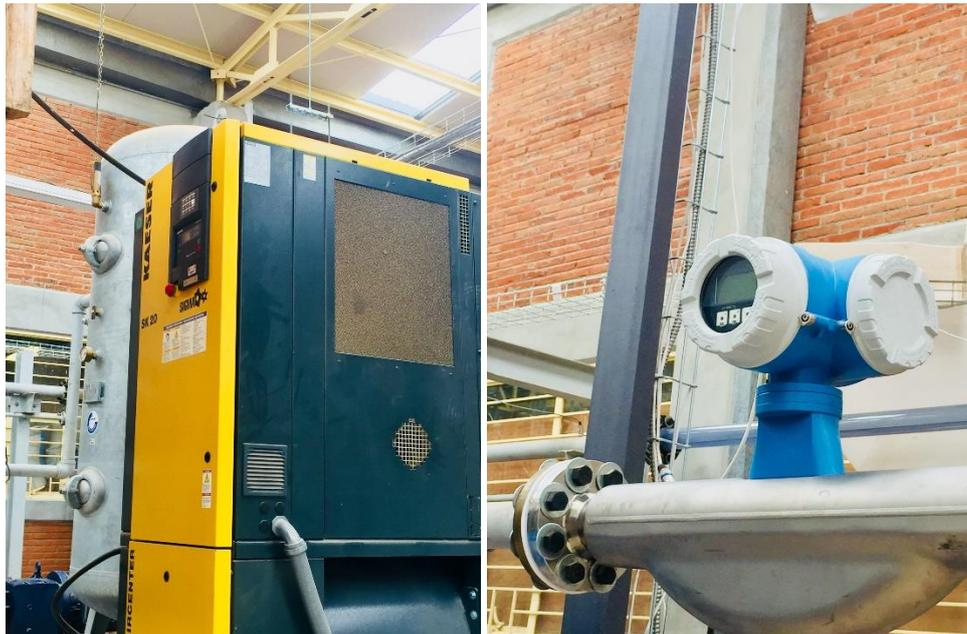
3.8 Compresor de aire marca Kaesser y Medidor de flujo másico para fase gaseosa por efecto Coriolis
