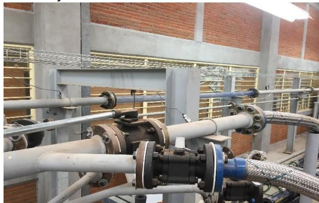
3.9 Inyección de aire, accesorio tipo "Y", y válvula de control de inyección de gas
