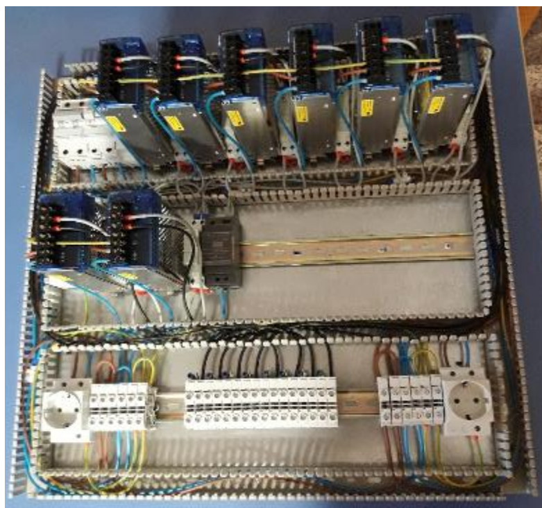
Figura 3.33 Conexión de todas las señales en la plancha.
