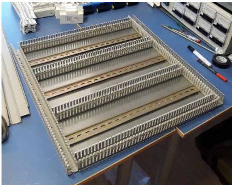
Figura 3.26 Colocación de carriles DIN sobre la plancha.
