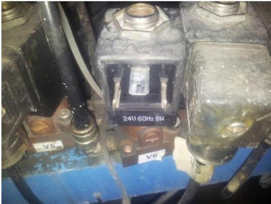
Figura 65. Mantenimiento de solenoides de electroválvulas
