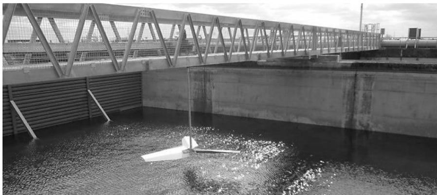
Figura 10. Agitador radial anóxico. [30]
