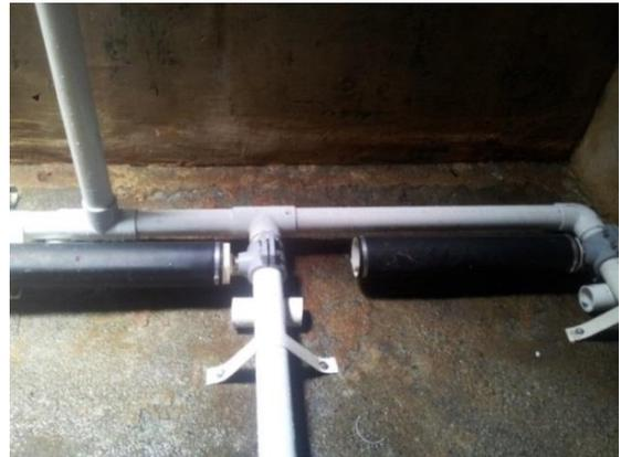
Figura 66. Instalación de un sistema de aireación
