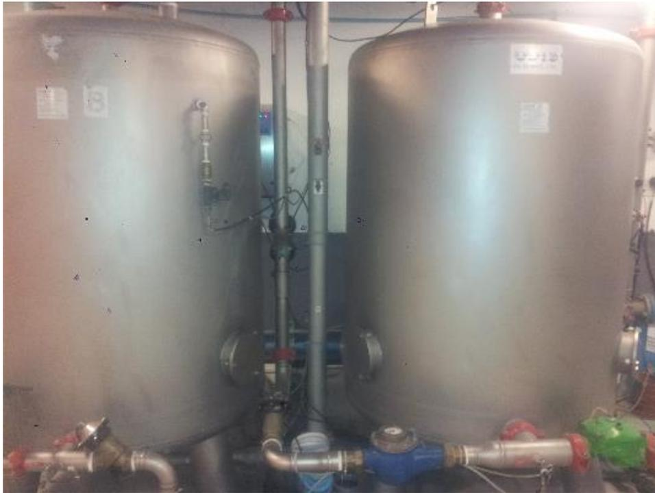
Figura 27. Tren de filtrado de la planta.
