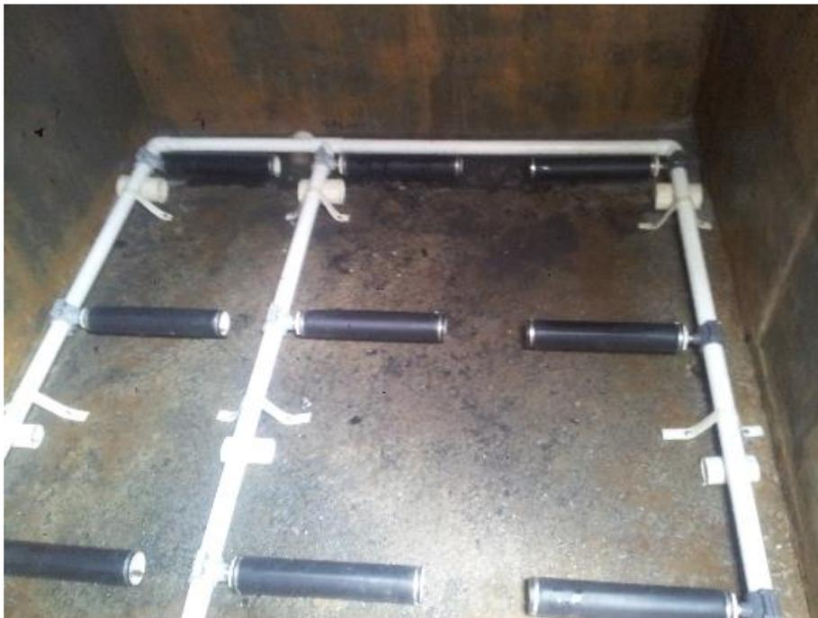
Figura 26. Difusores de aire en la cisterna de aguas grises.
