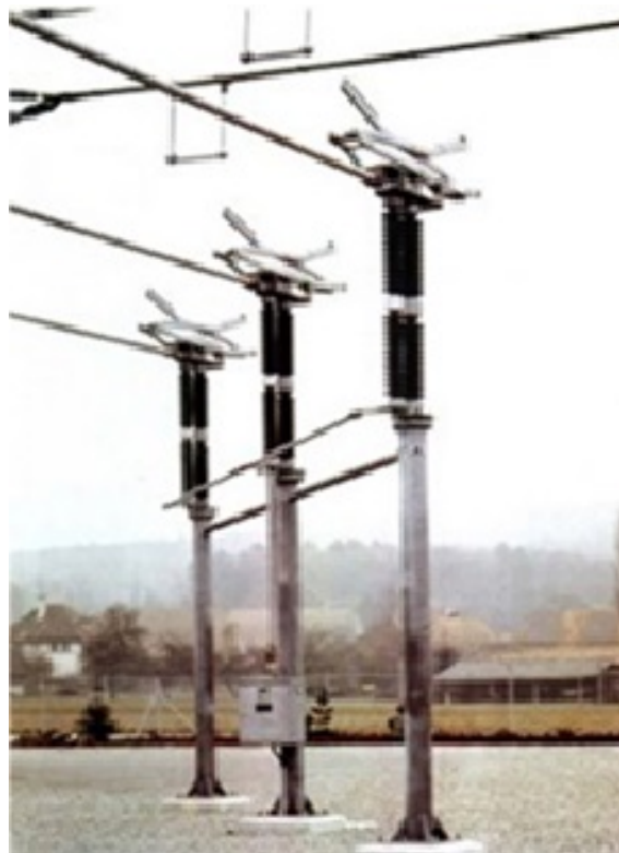
Figura 15: Seccionador pantógrafo.
