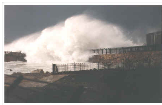
Fig.3.2.- Rebase del oleaje sobre un dique de protección que sirve además de camino.
