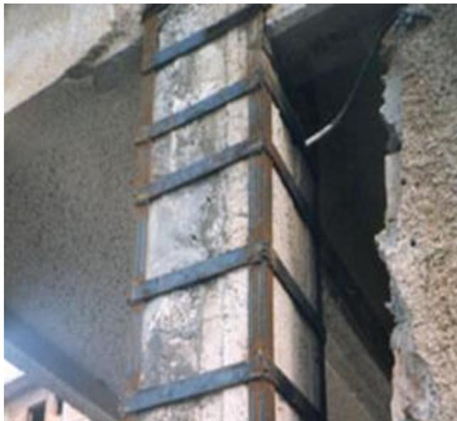
**Figura 1.2. Columna reparada con encamisado metálico**
