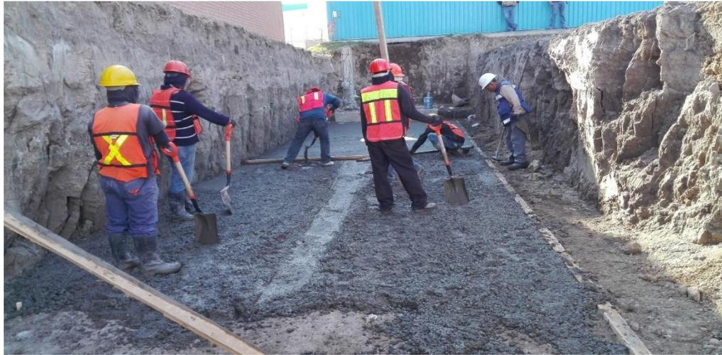
Figura 3-7 Colado de Plantilla concreto pobre  $f'c= 100 \text{ kg/cm}^2$
