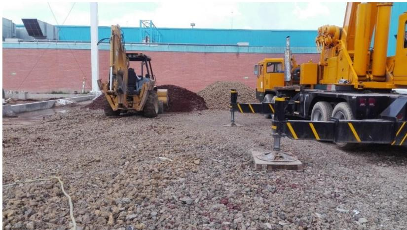
Figura 3-32 Colocación de tezontle para mejoramiento de suelo
