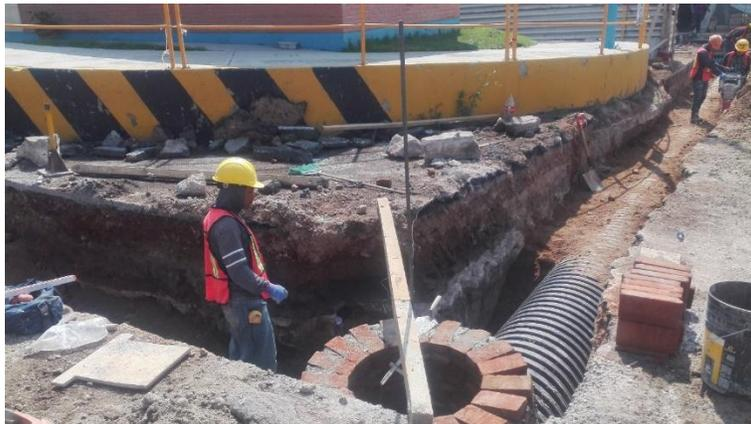
Figura 3-53 Relleno de zanjas con material tepetate
