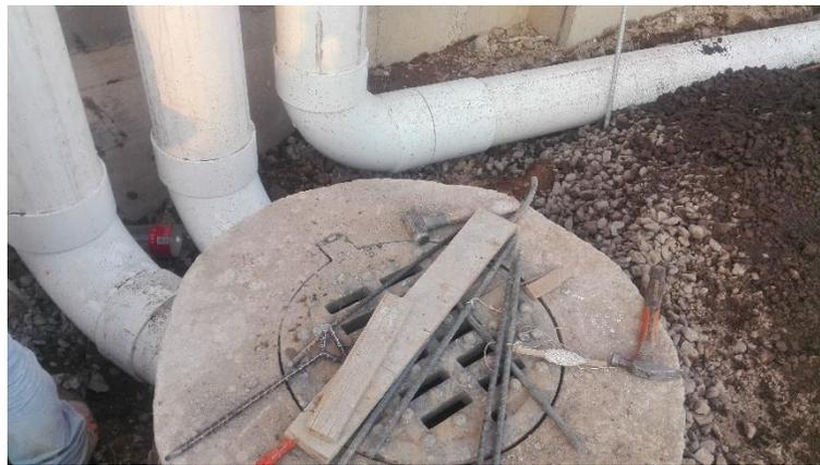
Figura 3-58 Conexión de tubería en pozo de visita
