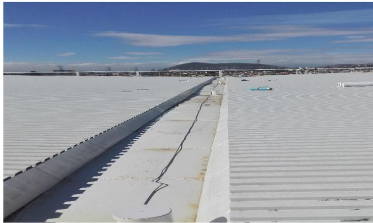
Figura 3-24 Canalón para bajadas pluviales
