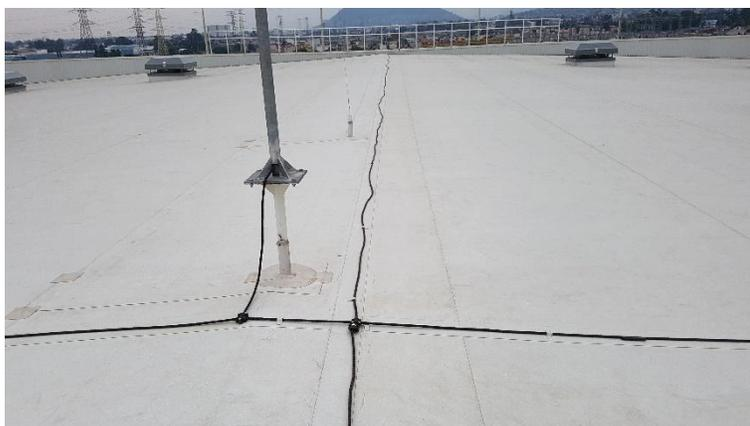
Figura 3-44 Conexión de antena pararrayos con red de cubierta
