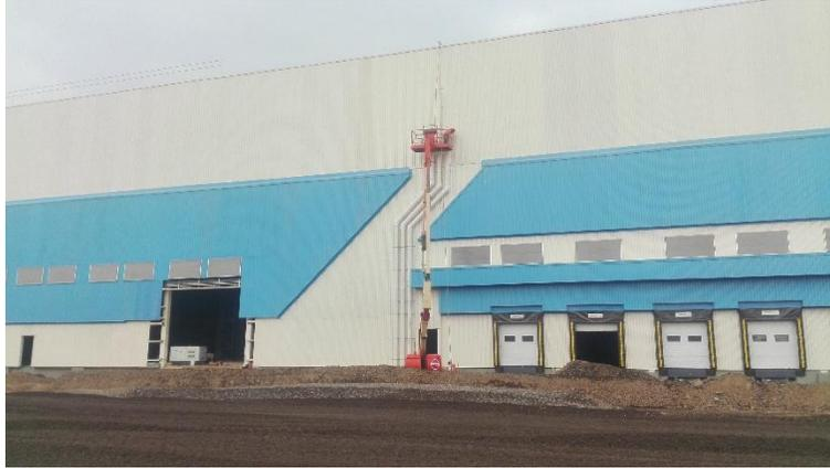
Figura 3-57 Bajada pluvial en eje 3-A
