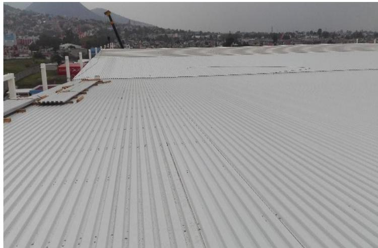
Figura 3-22 Laminación en cubierta
