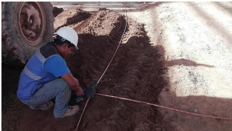
Figura 3-42 Soldadura de uniones
