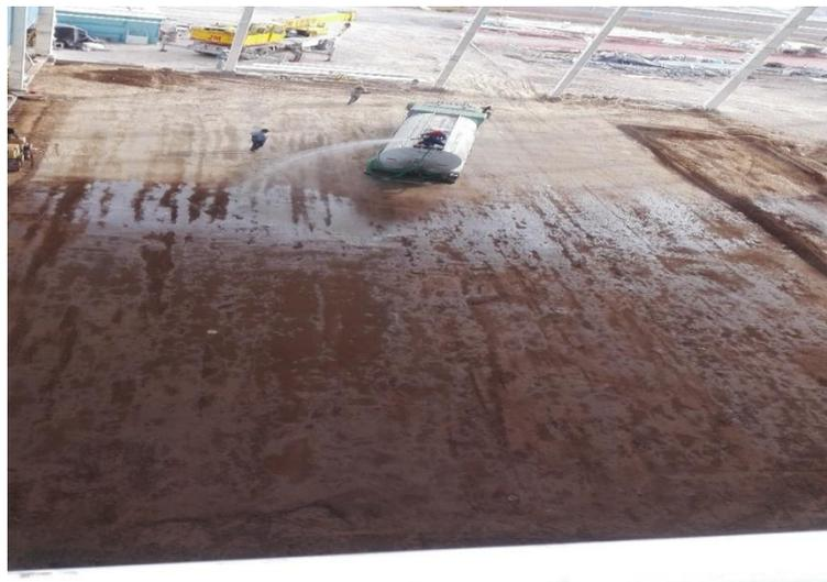
Figura 3-36 Riego de agua para mantener humedad
