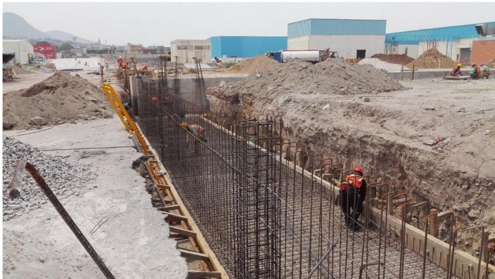
Figura 3-8. Armado de zapata, contratrabe y dados
