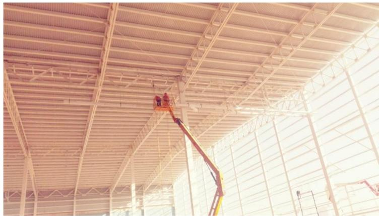
Figura 3-55 Instalación de tubería aérea con plataforma articulada.
