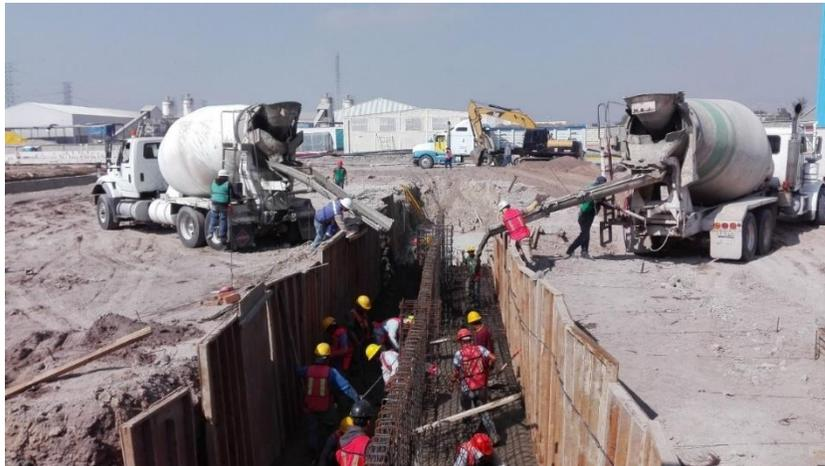
Figura 3-9. Colado de Zapata en cimentación
