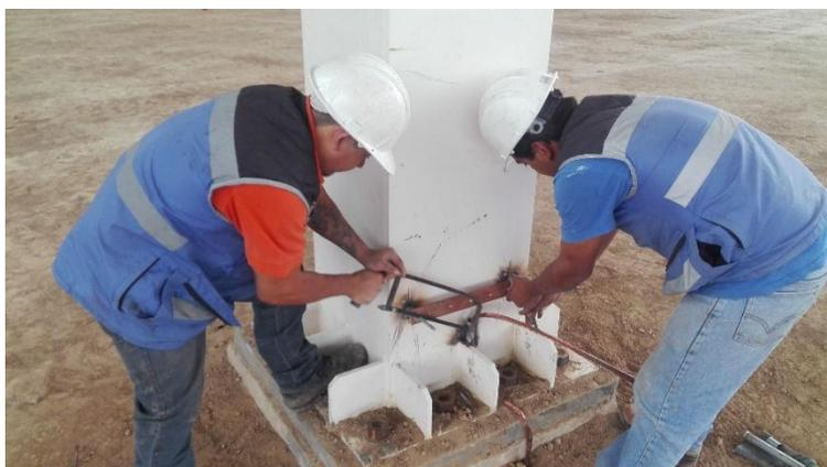
Figura 3-43 Conexión a terminal de cobre en columna
