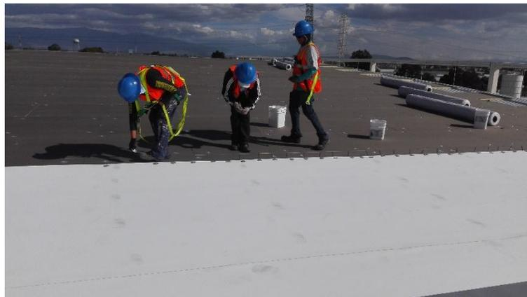
Figura 3-26 Colocación y pijado de aislante y membrana TPO
