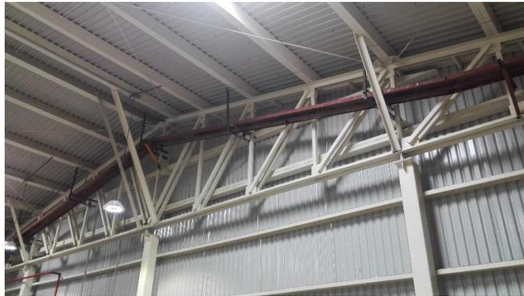
Figura 3-19 Paso de gato en armadura de zona de pateadores
