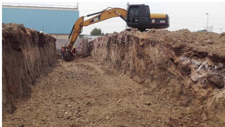
Figura 3-3 Excavación para Cimentación
