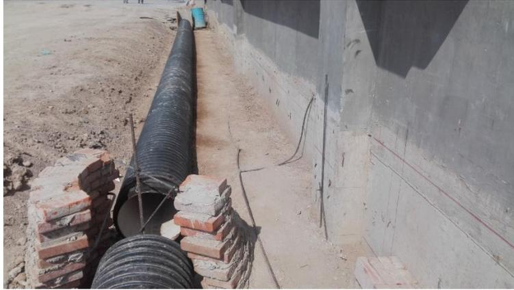
Figura 3-52 Colocación de tubería y construcción de pozo
