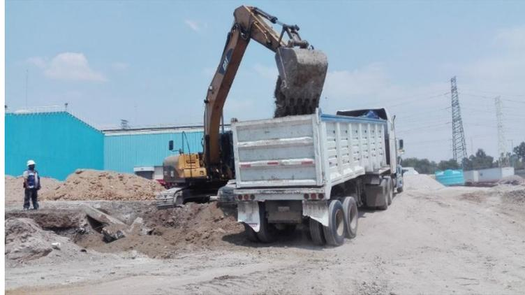
Figura 3-4 Carga y acarreo de material excavación
