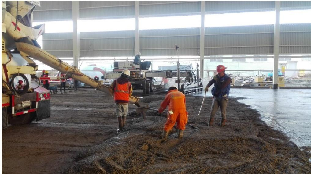
Figura 3-39 Colado de piso y nivelación con Somero laser en el fondo
