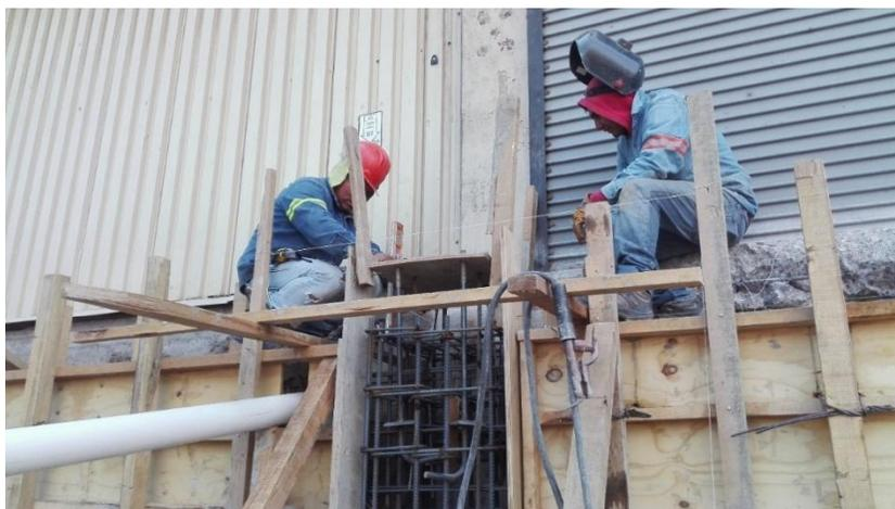
Figura 3-10. Colocación de anclas en dados
