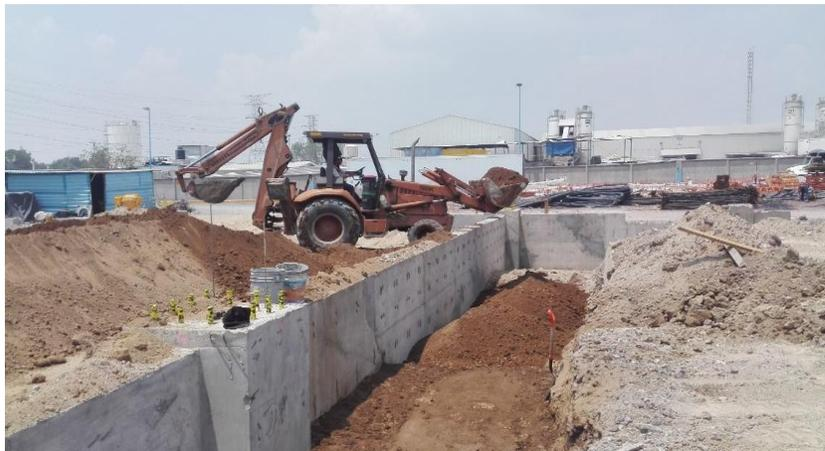
Figura 3-13 Relleno de zanjas con tepetate
