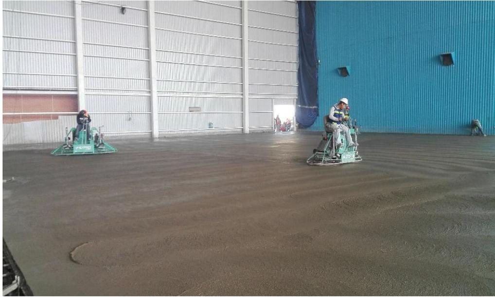
Figura 3-40 Pulido de piso con allanadoras de doble aspa
