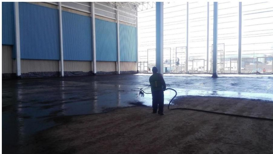
Figura. 3-38 Riego de impregnación en terracería de Cedis
