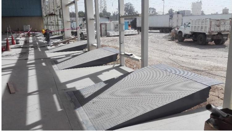
Figura 3-47 Instalación de rampas niveladoras
