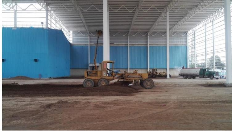
Figura 3-34. Motoconformadora tendiendo Grava controlada
