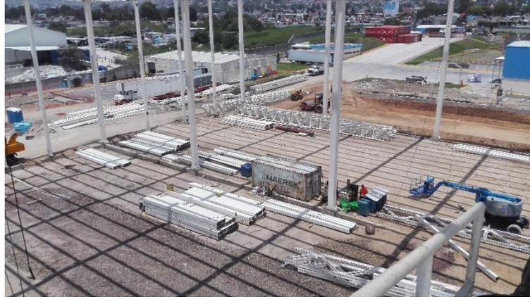
Figura 3-18 Ubicación de material estructural para montaje
