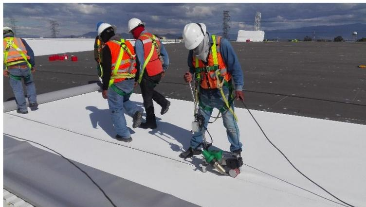
Figura 3-27 Termofusión en membrana TPO
