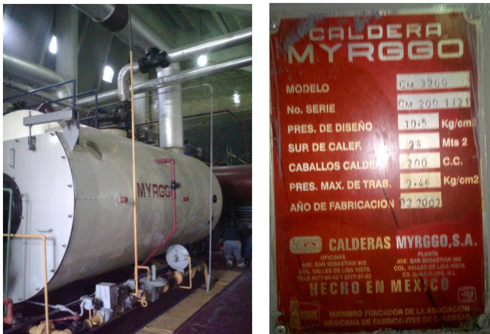
Figura 20. Caldera de la Alberca con su placa de datos. Fuente: (MYRGGO)
