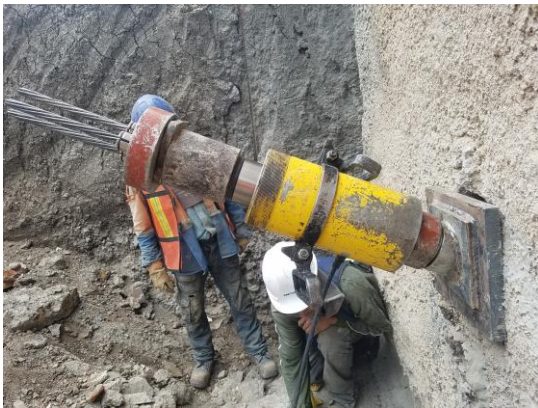
Figura 5.57 Montaje de equipo de tensado
