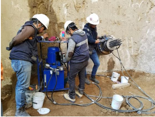
Figura 5.84 Aplicación de cargas con equipo de tensado hidráulico
