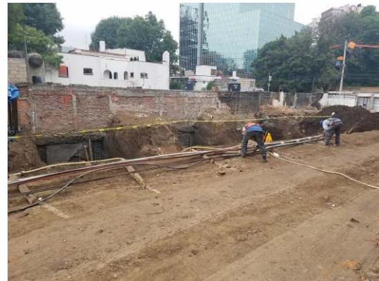
Figura 5.46 Fabricación de anclas
