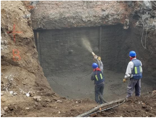
Figura 5.55 Lanzado de muro por vía seca
