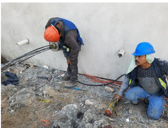
Figura 5.11 Puesta en tensión del ancla
