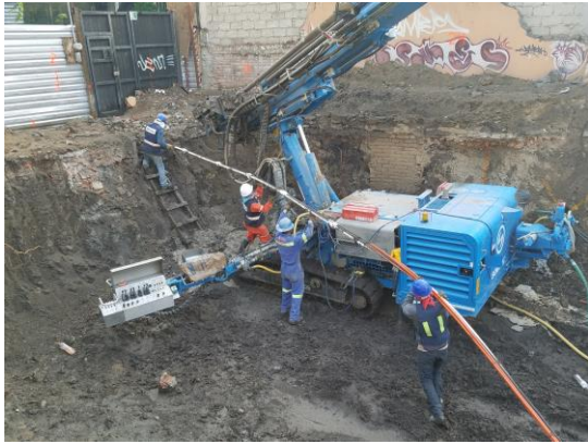
Figura 5.49 Equipamiento del ancla dentro de la perforación
