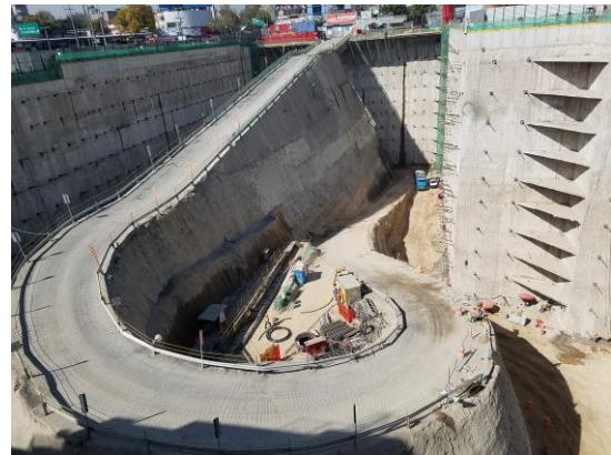
Figura 5.87 Inicio del décimo nivel de anclas
