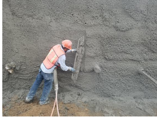
Figura 5.8 Perfilado del tramo de muro estructural
