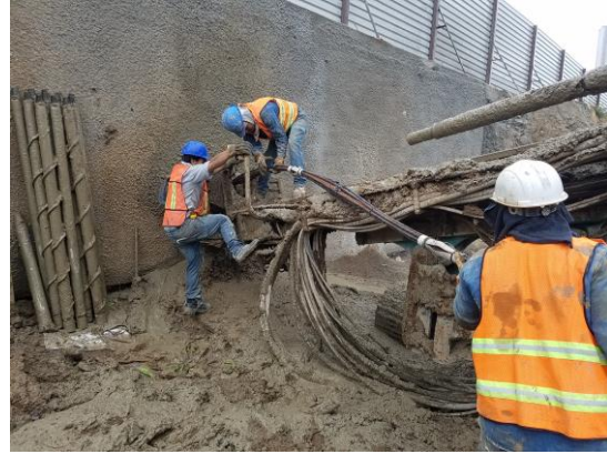
Figura 5.32 Equipamiento de ancla
