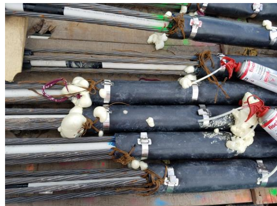
Figura 5.71 Tapón de espuma en la interfaz de bulbo-longitud libre
