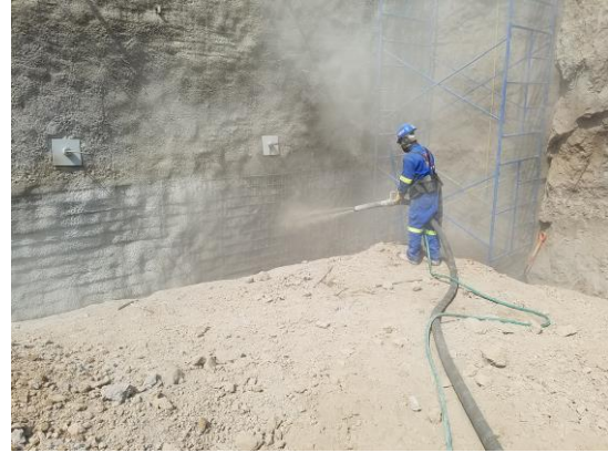
Figura 5.20 Lanzado de muro por vía seca
