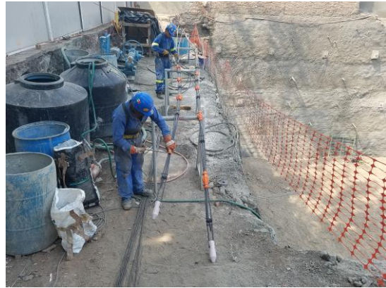
Figura 5.14 Fabricación de anclas
