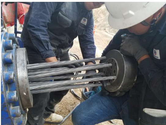
Figura 5.82 Colocación de bloque de arrastre
