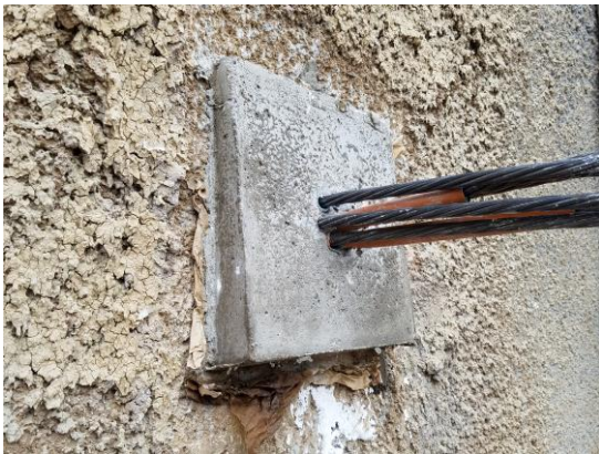
Figura 5.33 "Grout" de mortero de repartición
