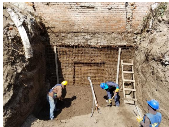
Figura 5.54 Colocación de la malla electrosoldada 6x6-4/4
