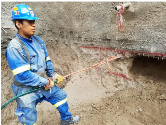
Figura 5.17 Inyección del ancla
