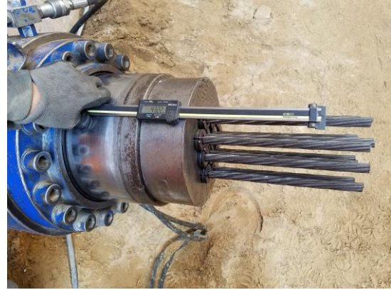
Figura 5.85 Medición de la elongación del conjunto de cables torón
