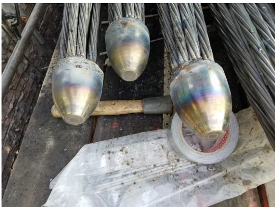
Figura 5.70 Punta cónica o de bala
