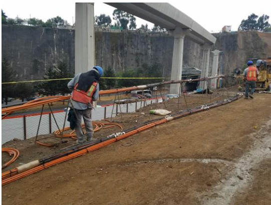
Figura 5.27 Fabricación de anclas
