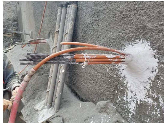
Figura 5.34 Inyección de anclaje y calafateado con yeso
