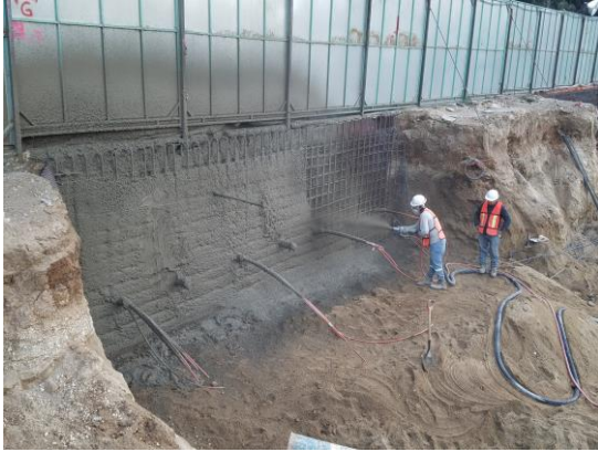
Figura 5.7 Lanzado de concreto por vía húmeda
