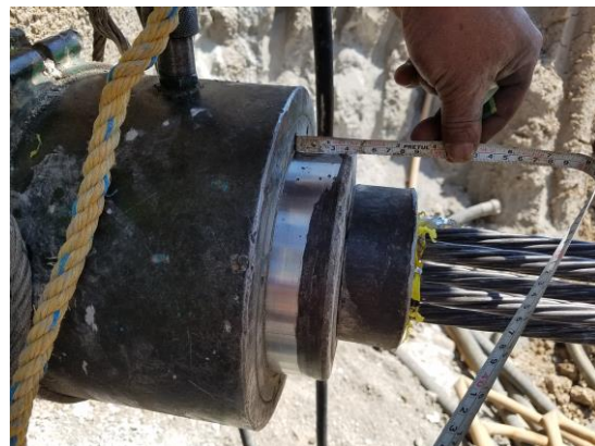
Figura 5.36 Medición de elongación del ancla
