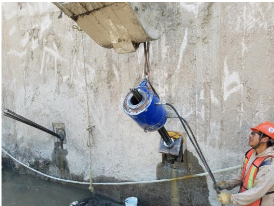
Figura 5.80 Montaje del gato hidráulico
