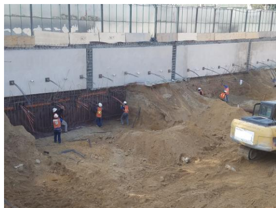
Figura 5.12 Inicio del 2.º nivel de anclas y de tramos de muro estructural
