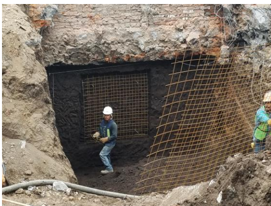
Figura 5.53 Colocación de la zapata de reacción
