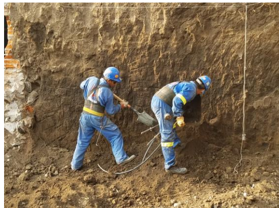
Figura 5.18 Afine del tramo de muro y labrado para dado de reacción
