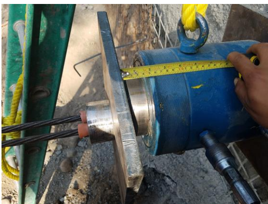
Figura 5.23 Medición de la elongación de torones
