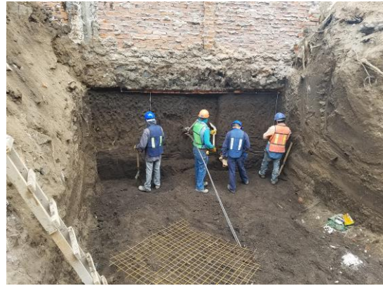
Figura 5.52 Afine de muro y labrado para la zapata de reacción
