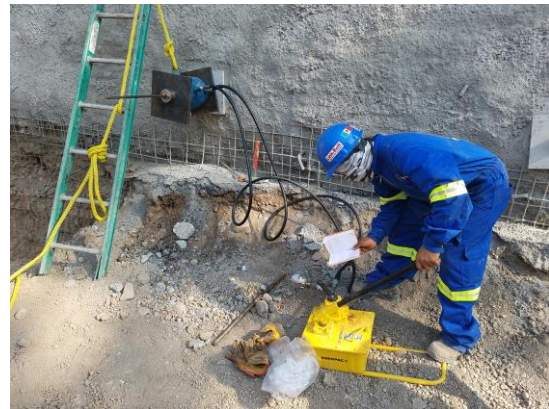
Figura 5.22 Puesta en tensión del ancla
