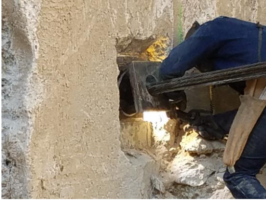
Figura 5.78 Colocación de silleta metálica sobre la placa de reservación
