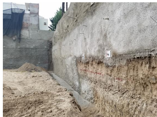
Figura 5.24 Inicio del 3.º nivel de anclas
