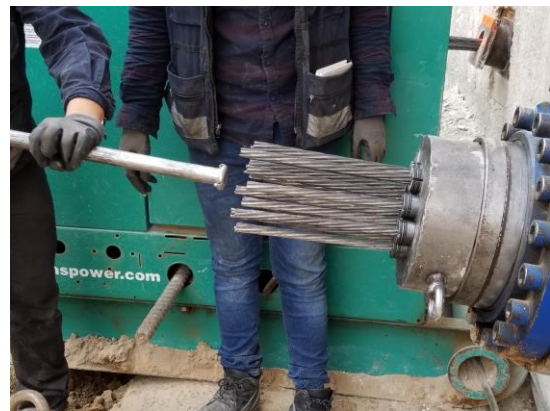
Figura 5.83 Colocación y apretado de cuñas de arrastre
