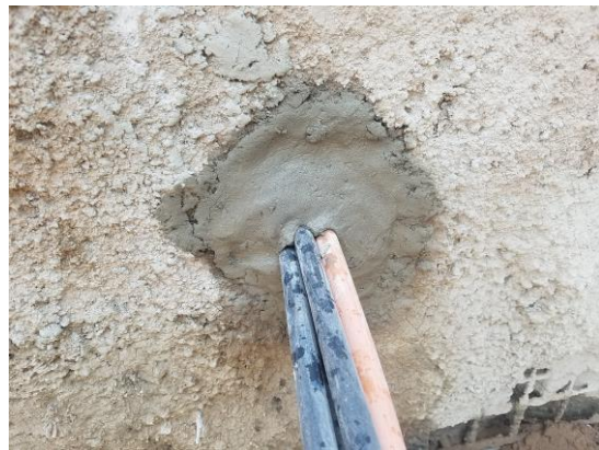
Figura 5.16 Calafateado (obtención) de la perforación
