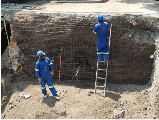
Figura 5.19 Habilitado de malla electrosoldada
