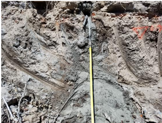
Figura 5.51 Inyección del ancla
