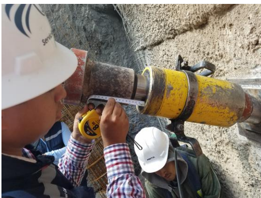
Figura 5.59 Medición de la elongación del ancla
