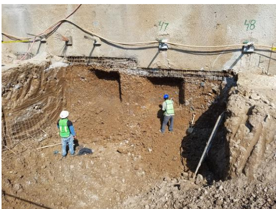
Figura 5.29 Afine del tramo de muro y labrado para zapata de reacción
