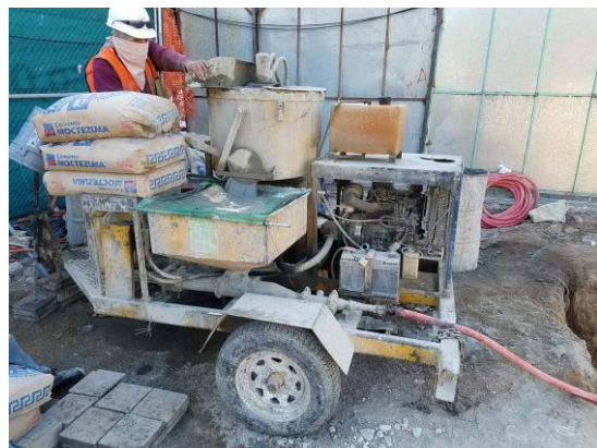
Figura 5.4 Fabricación de lechada
