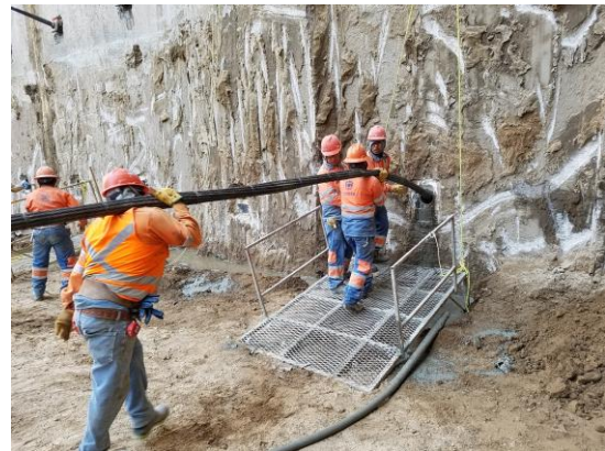
Figura 5.75. Equipamiento del ancla
