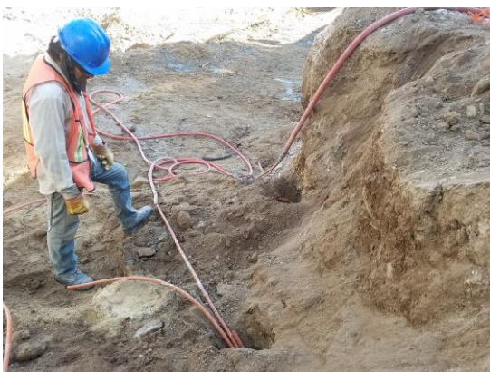
Figura 5.5 Inyección de lechada
