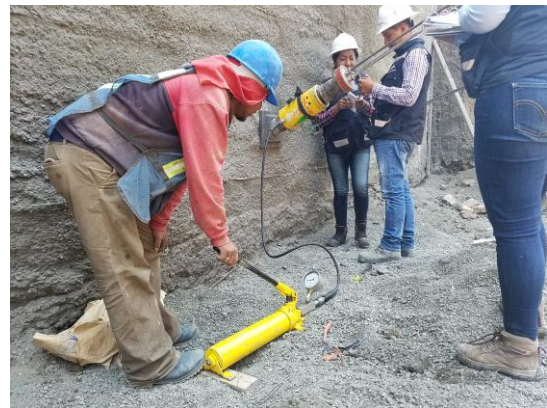
Figura 5.58 Puesta en tensión del ancla
