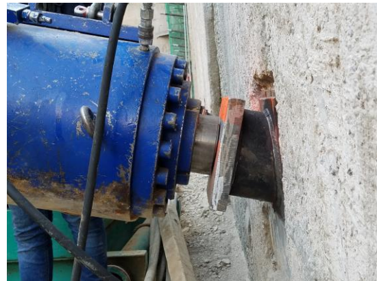
Figura 5.81 Asentado del bloque en la silleta
