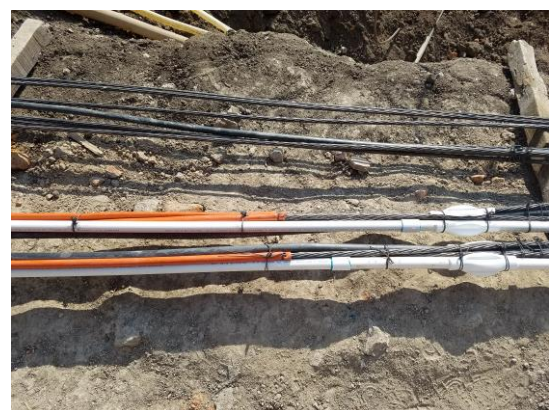
Figura 5.48 Interfaz longitud libre-longitud de bulbo
