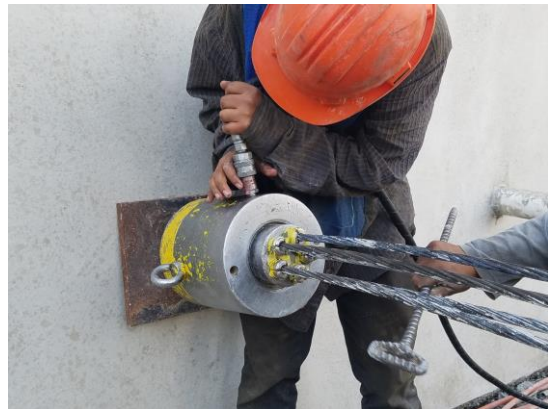
Figura 5.10 Montaje de gato y colocación de cuñas y "queso" de arrastre
