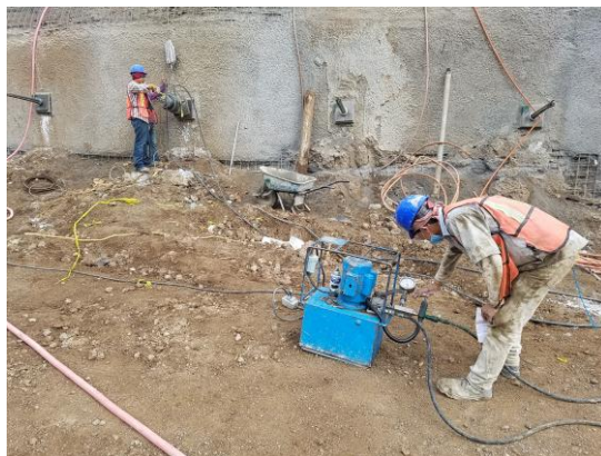
Figura 5.35 Puesta en tensión del ancla
