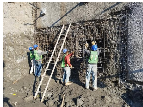
Figura 5.30 Colocación de acero de zapata de reacción y de malla electrosoldada
