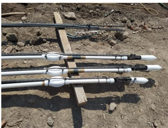
Figura 5.47 Tubo de reinyección con "manguitos" y punta plástica tipo "bala"
