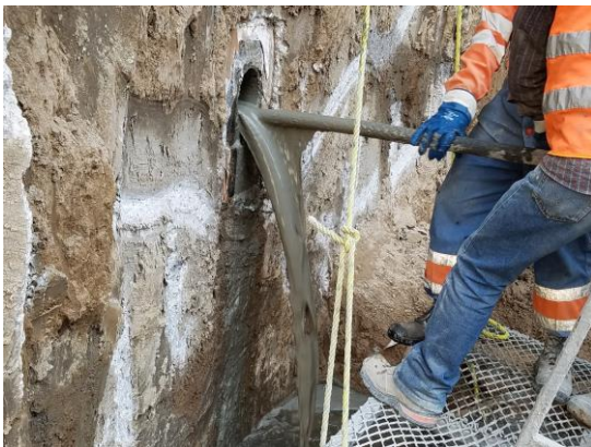
Figura 5.74 Inyección de lechada de vaina
