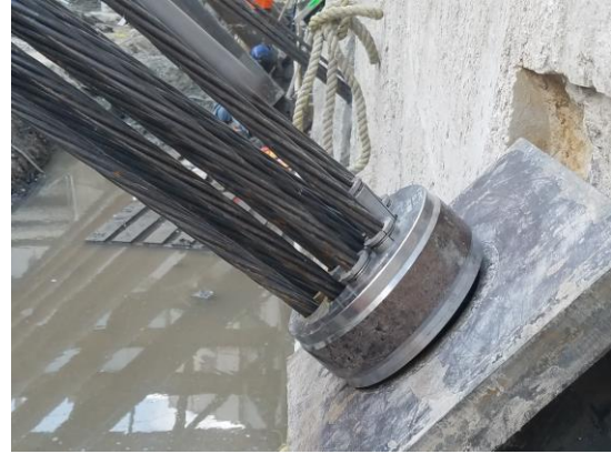
Figura 5.79 Colocación del "queso" y cuñas de bloqueo
