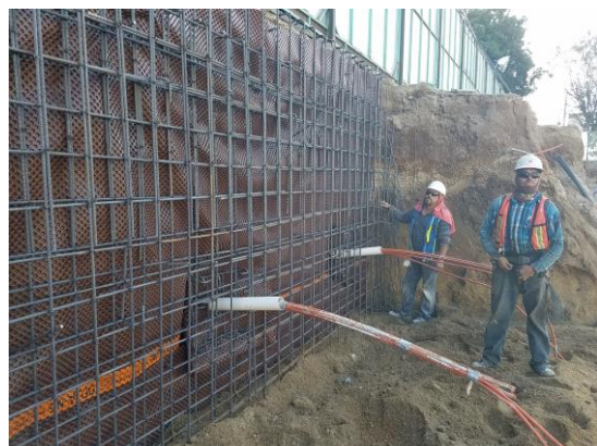
Figura 5.6 Habilitado de acero del tramo de muro estructural
