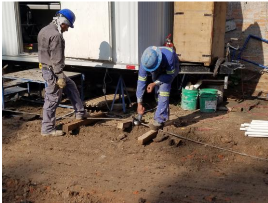
Figura 5.45 Corte del cable torón
