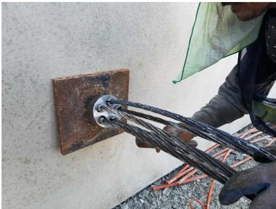
Figura 5.9 Colocación de cuñas y "queso" de tensión
