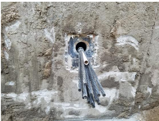
Figura 5.76 Tubo de PVC para reinyección del ancla
