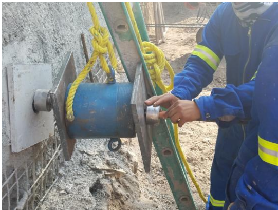
Figura 5.21 Colocación del equipo de tensado
