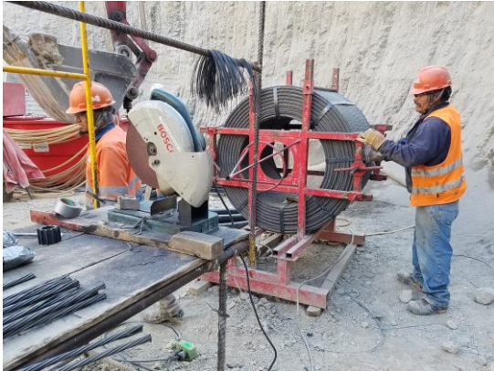
Figura 5.66 Base de la bobina del cable torón
