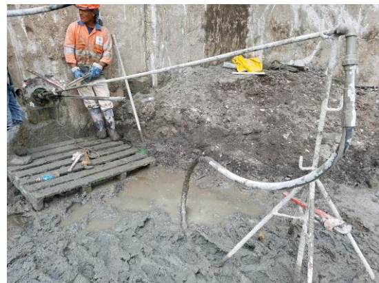
Figura 5.77 Reinyección del ancla tipo IRS
