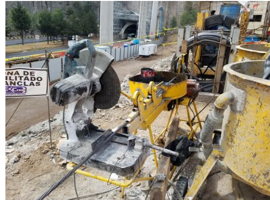
Figura 5.26 Extracción y corte de torón
