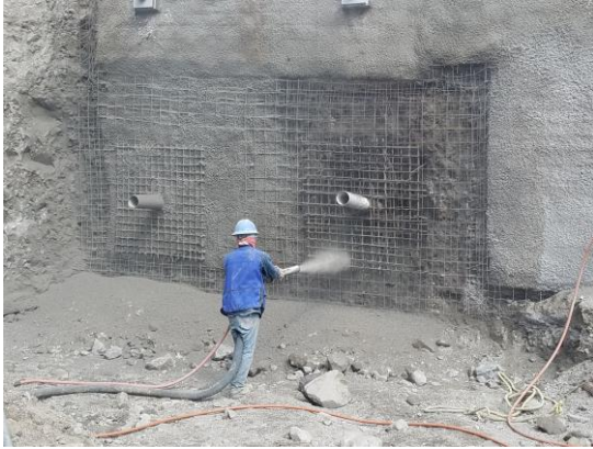
Figura 5.31 Lanzado de muro por vía seca
