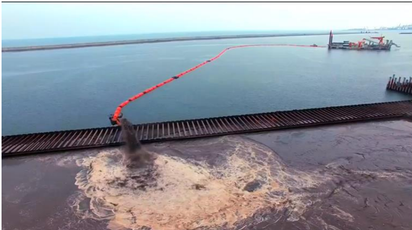
Obras de protección y vialidades
