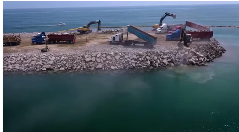
Construcción de terminales e instalaciones
