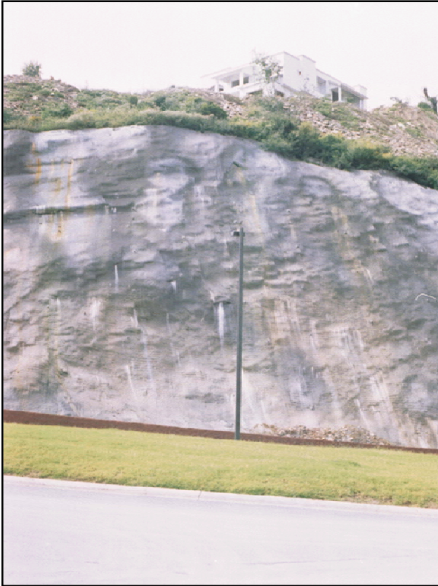
Fotografía IV.2.3.2. Estabilización con concreto lanzado.
