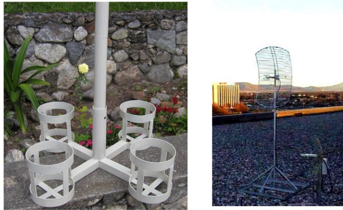
Figura 4.8 Montajes no penetrables.
