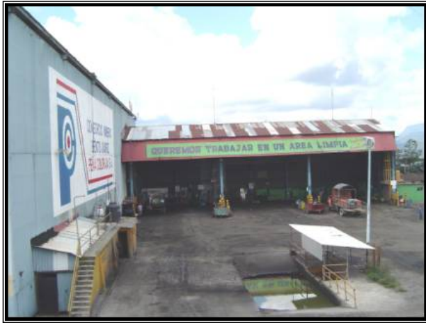
Figura 4. Área de mantenimiento del taller La Encantada patio general y rampa de lavado
