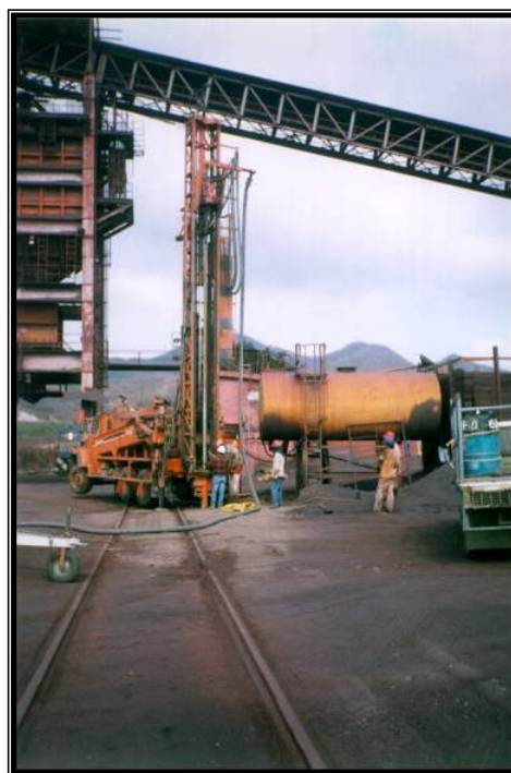
Figura 10 Tanque de diesel en la zona de embarque
