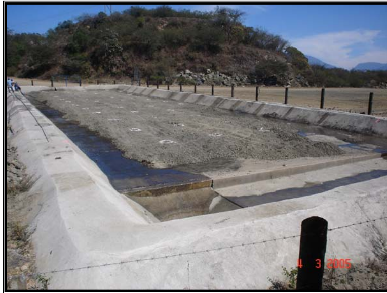
Figura 50. Prueba realizada para verificar el escurrimiento del lixiviado hacia la canaleta
