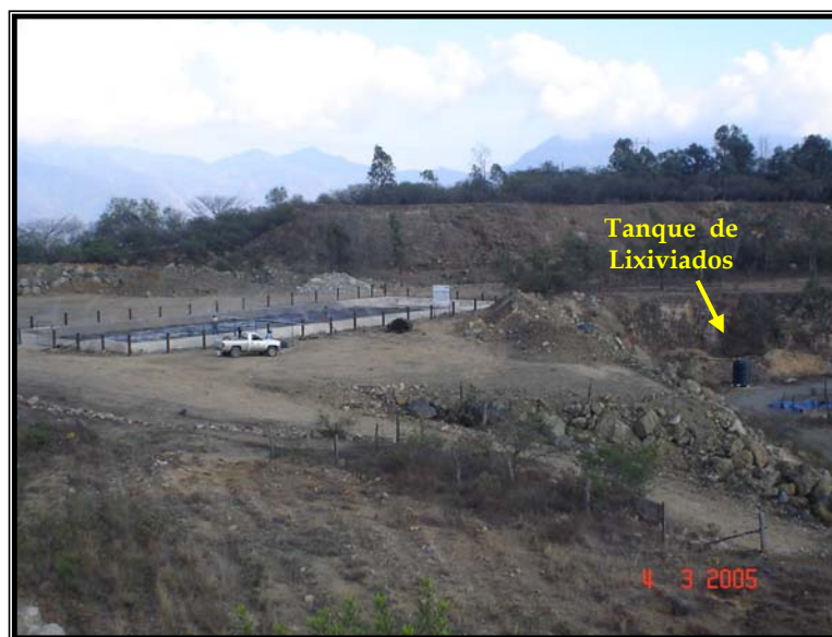
Figura 54. Tanque de captación de lixiviados colocada a 12 m debajo de la celda
