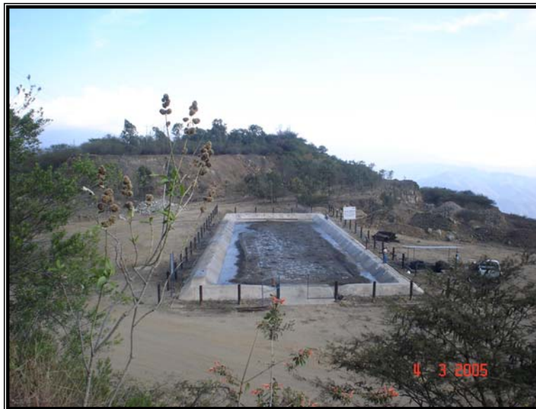
Figura 49. Vista panorámica con los tanques de almacenamiento de lodos y la cerca de alambre
