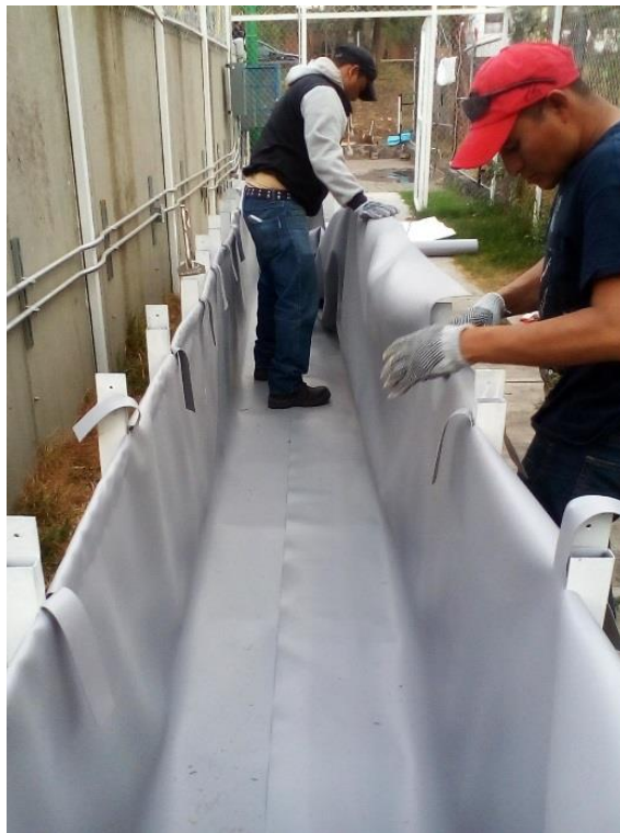
Figura 9 Colocación de la geomembrana de PVC
