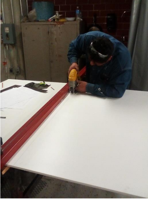
Figura 10 Corte de las láminas de PVC
