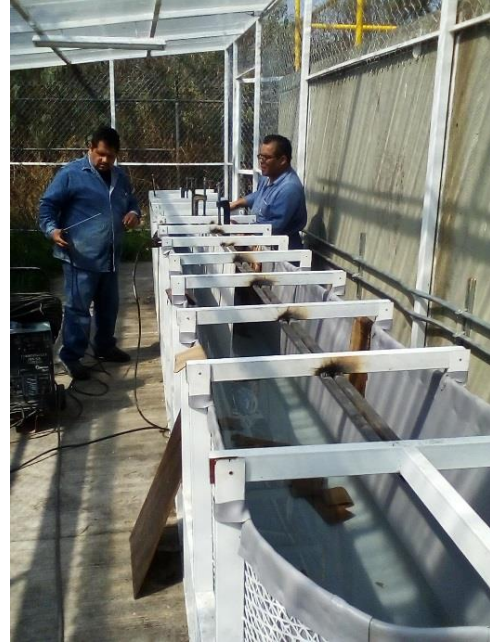
Figura 11 Habilitado de la estructura soporte de la mampara
