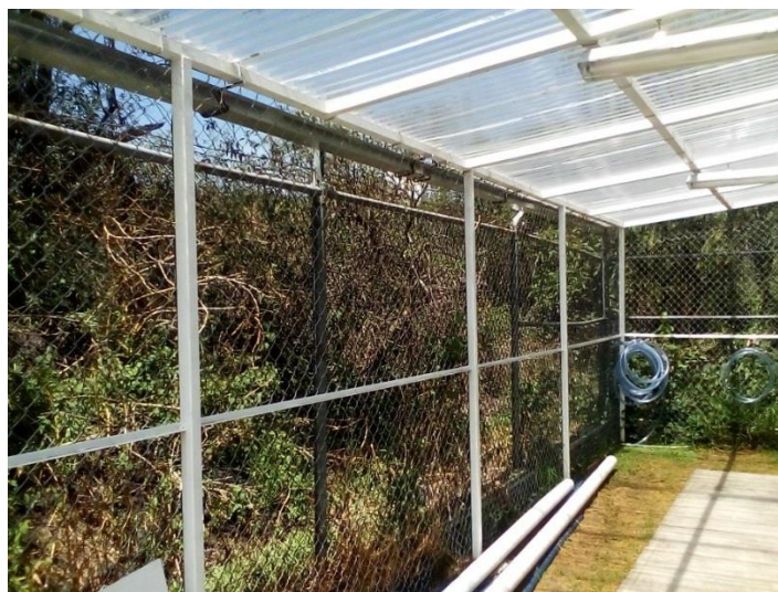
Figura 18 Estructura de PTR y malla ciclónica, vista desde adentro
