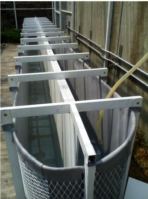
Figura 12 Estructura soporte terminada y mampara colocada
