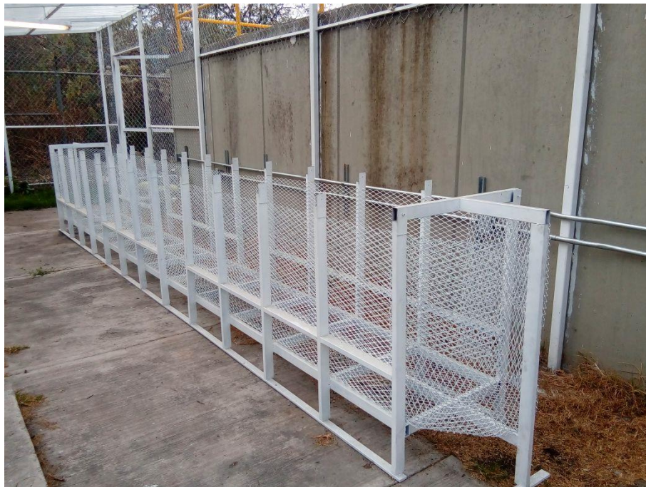
Figura 8 Colocación y ensamblado de la estructura de acero en la Planta Piloto
