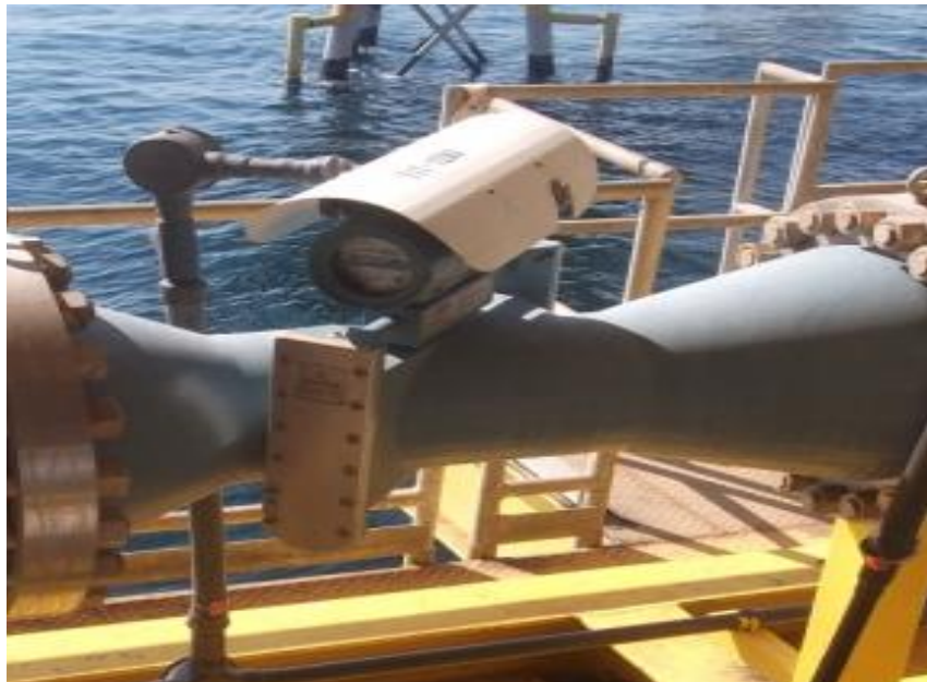
Figura 3.17 Medidor ultrasónico (Pemex Exploración y Producción, 2014)
