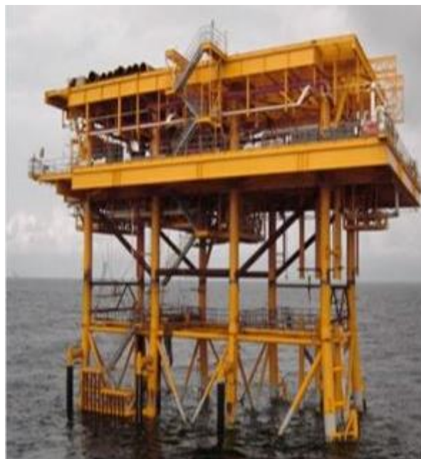
Figura 2.2 Superestructura de una plataforma marina fija (Gil, 2010)
