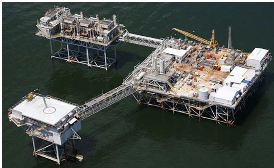
Figura 1.5 Plataforma Grand Isle en Louisiana (CorEnergy XXI, 2018)
