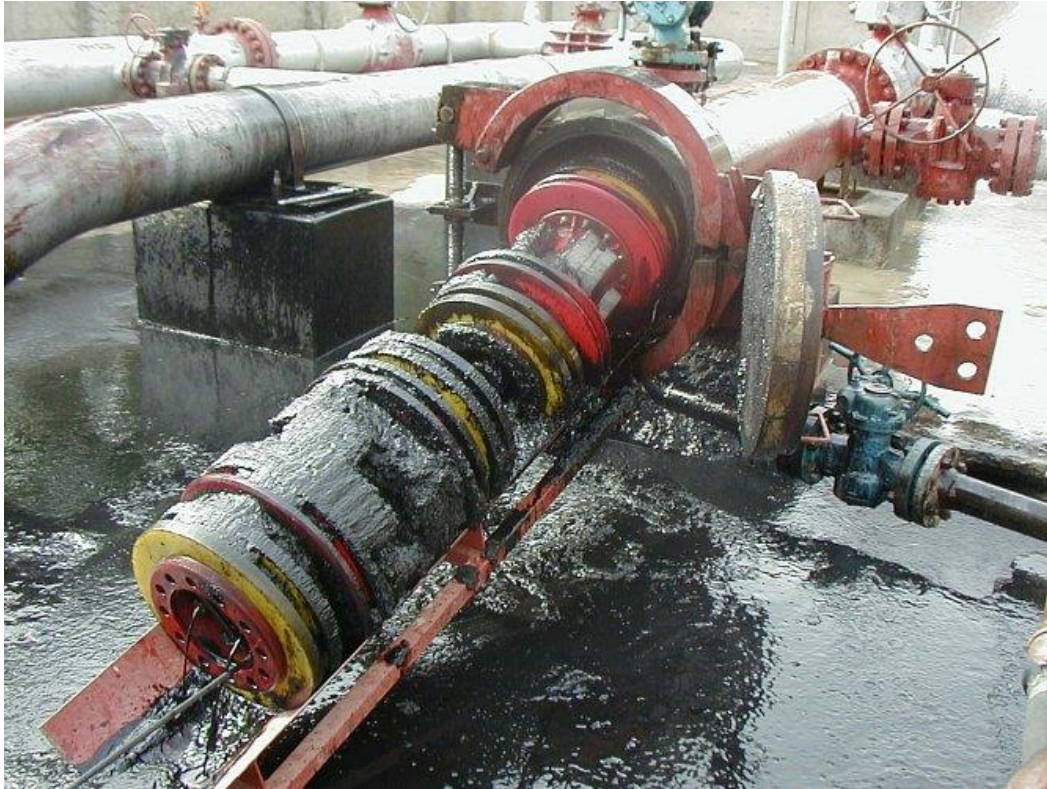
Figura 3.23 Trampa receptora de los ELI (Pigtek Ltd., 2018)
