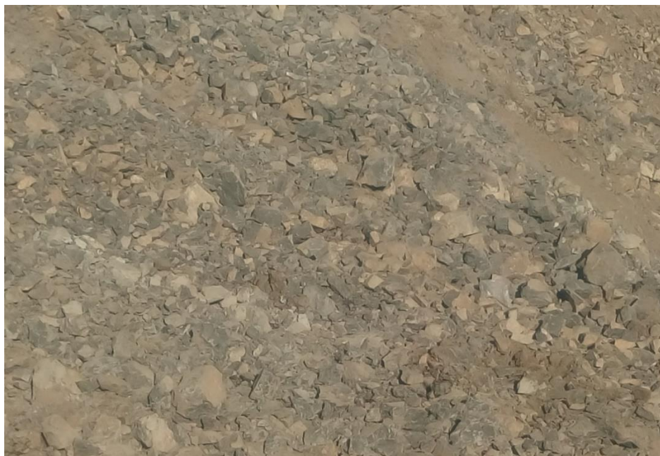
Figura 8. Voladura con la variación del Taco, Bordo y Espaciamiento (02-03-2018)
