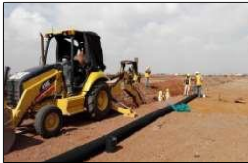
Figura 7 Colocación de drenaje horizontal, (Fuente: Fotografía tomada por la empresa SIPNA)
