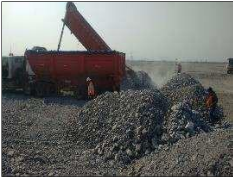
Figura 19 Colocación de material de precarga (Fuente: Fotografía tomada por la empresa SIPNA)
