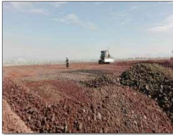
Figura 8 Colocación de tezontle, (Fuente: Fotografía tomada por la empresa SIPNA)
