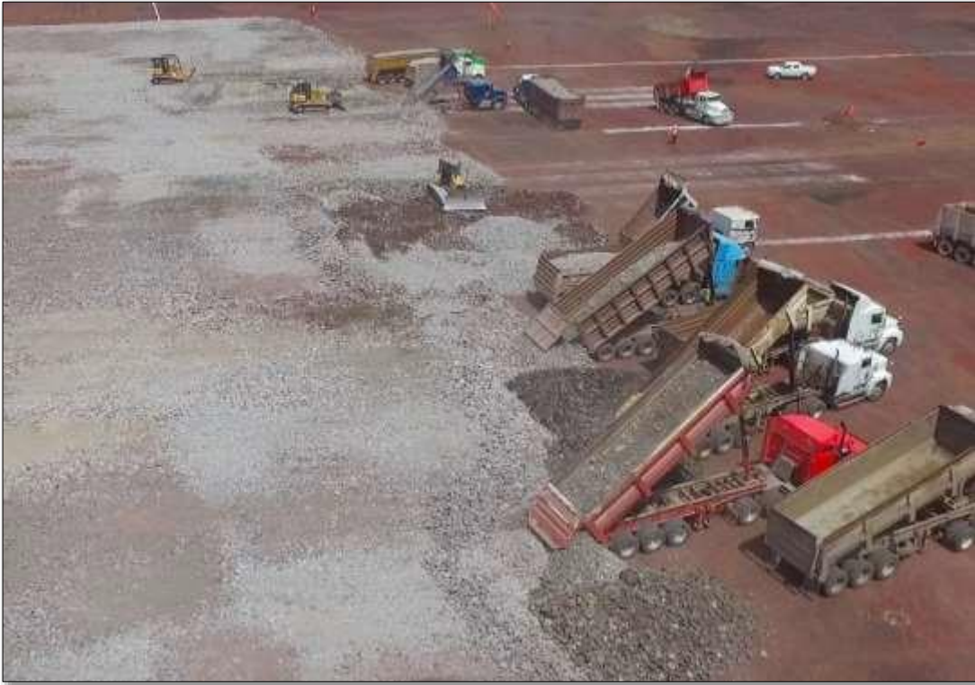
Figura 15 Colocación de material pesado en Plataforma 100, marzo 2018. (Fuente: Fotografía tomada por la empresa SIPNA)
