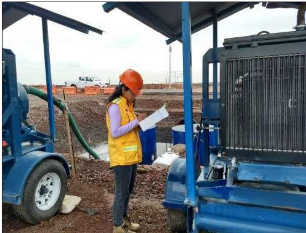
Figura 23 Medición de horómetros de bombas, (Fuente: Tomada por la autora)
