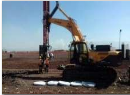
Figura 6 Hincado de drenes verticales, (Fuente: Fotografía tomada por la empresa SIPNA)
