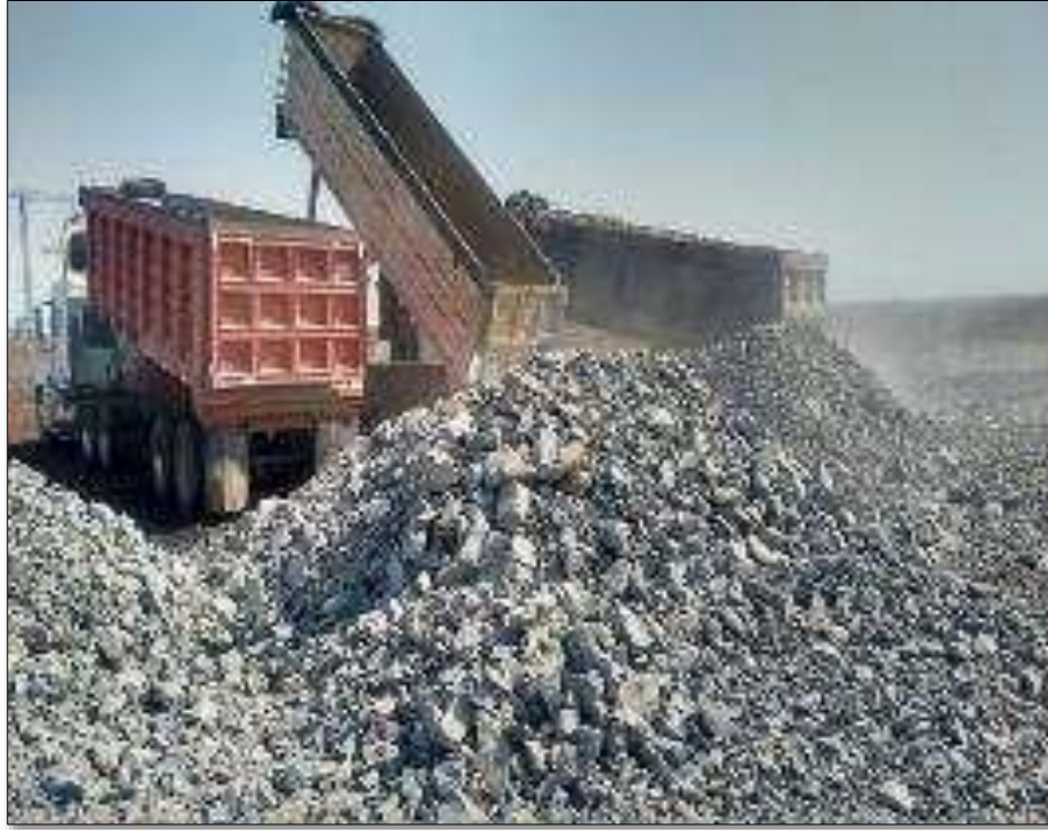
Figura 18 Colocación de material de precarga (Fuente: Fotografía tomada por la empresa SIPNA)
