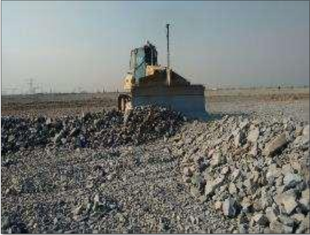
Figura 20 Tendido de material de precarga (Fuente: Fotografía tomada por la empresa SIPNA)
