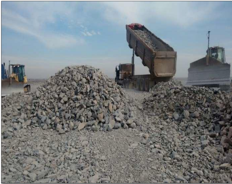
Figura 21 Colocación de material de precarga (Fuente: Fotografía tomada por la empresa SIPNA)
