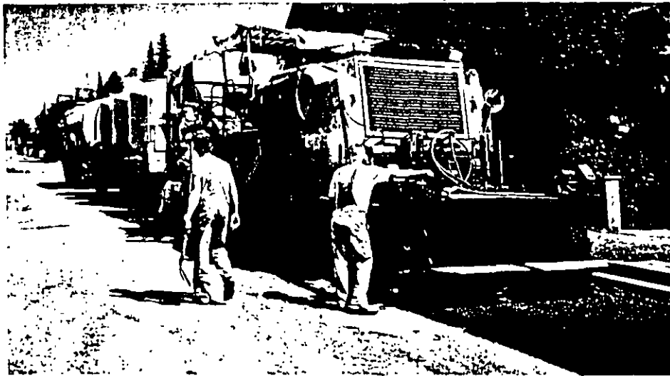
La emulsión asfáltica se utiliza para reciclar y cubrir una capa con restos de alquitrán.
