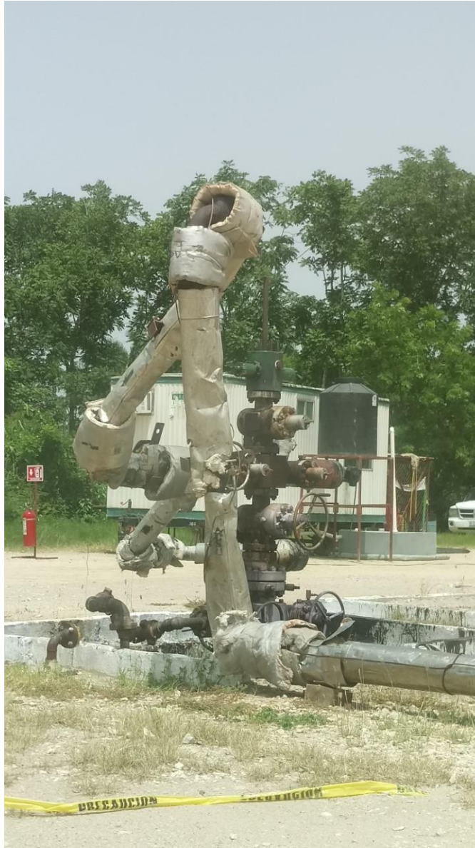
Figura 3.1 Cabezal Isotérmico Para Proceso de Inyección de Vapor
