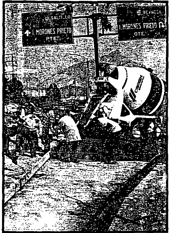
Colado con Cimbra Fija.
