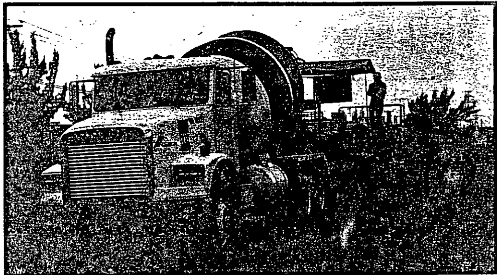
Camión Revolvedor descargando Concreto en Pavimentadora.
