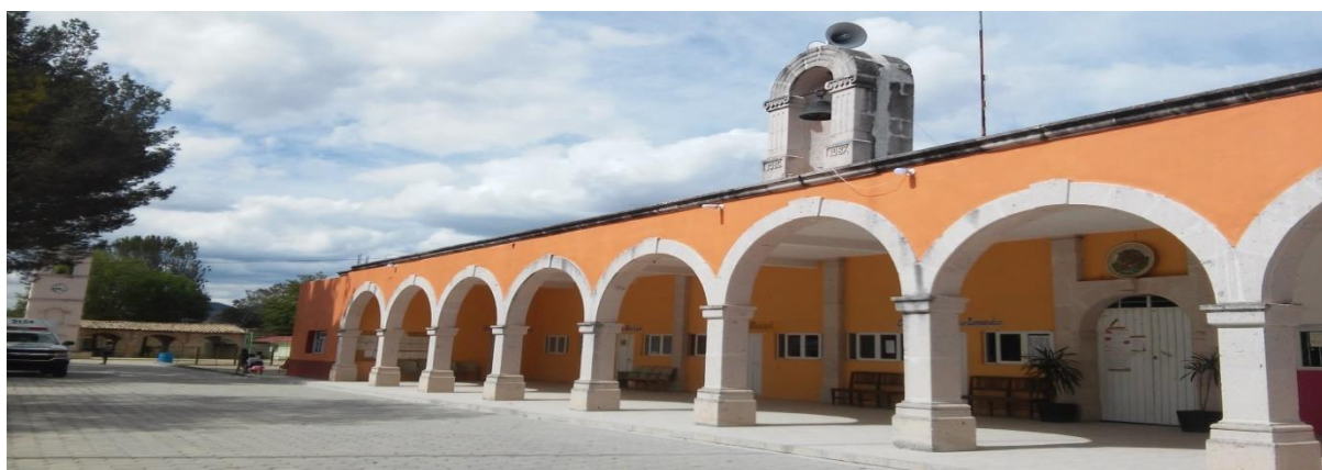
Fotografía. 3. Presidencia municipal. LCB 2017, fotografía propia.
