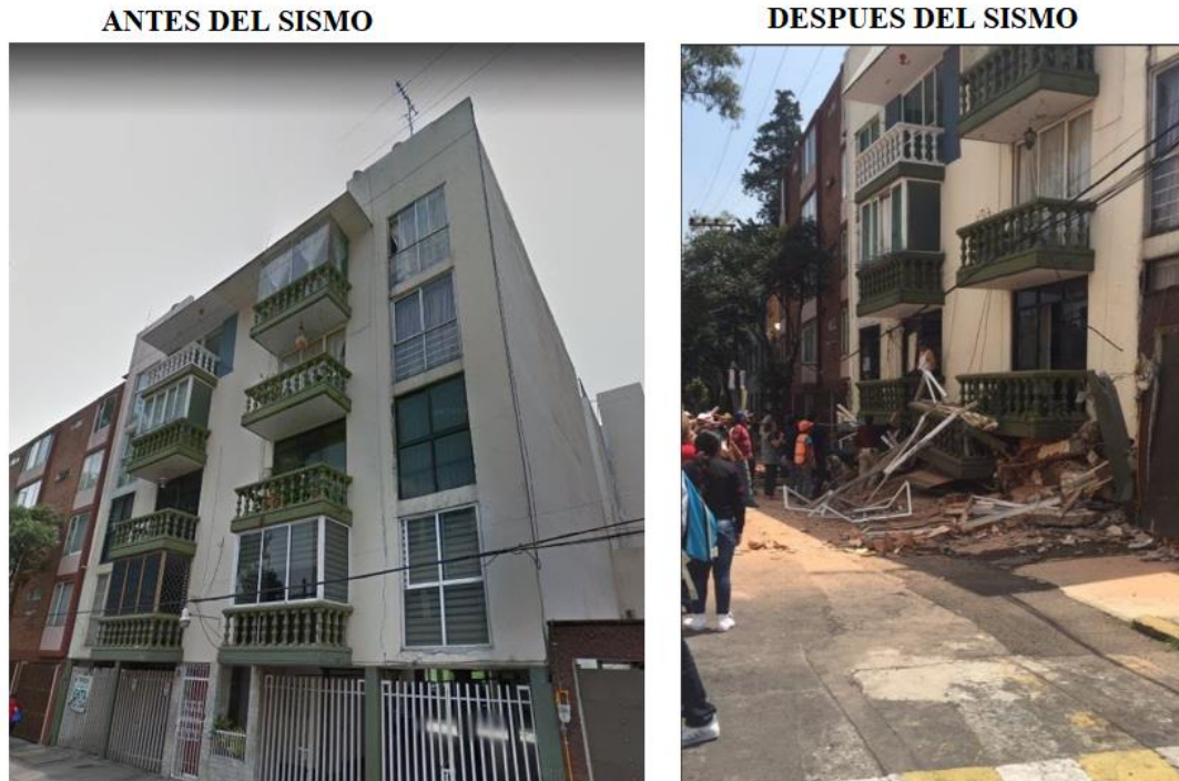
Figura 1-1 Edificio colapsado en sismo de septiembre de 2017 (Sistema Estructural: Marcos de concreto y muros diafragma de mampostería). Fuente: Visualizador de inmuebles con daños para la Ciudad de México, ERN.
