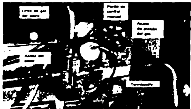
FIGURA A5-37 Válvula de gas combinada. (Cortesía de Borg-Warner Central Environmental Systems, Inc.)
