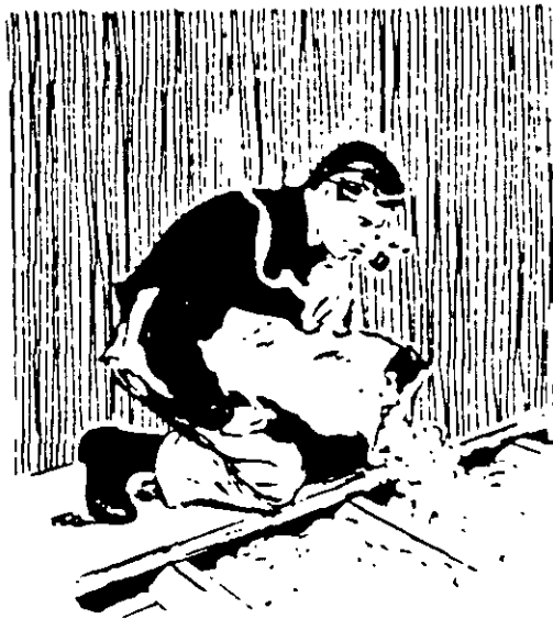
FIGURA R27-5 Aislamiento de relleno suelto.
