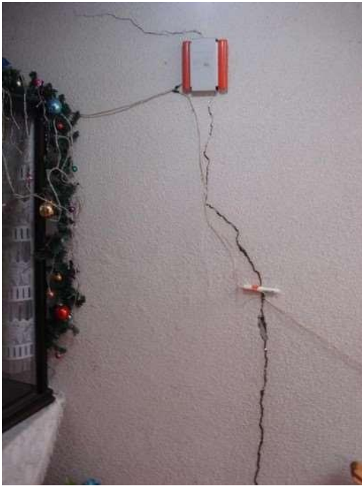
Fotografía 4. Fractura en la pared de las escaleras.
