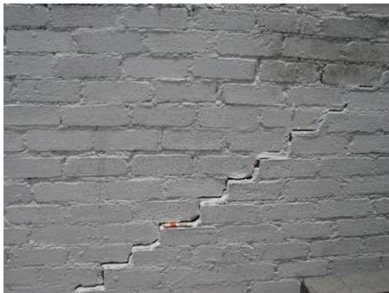
Fotografía 23. Fracturas en la pared.
