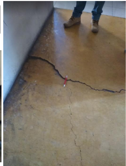
Fotografía 34. Fractura en el pasillo de la sala a la cocina.
