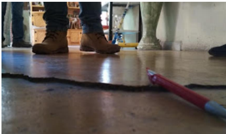
Fotografía 34. Fractura en el pasillo de la sala a la cocina.
