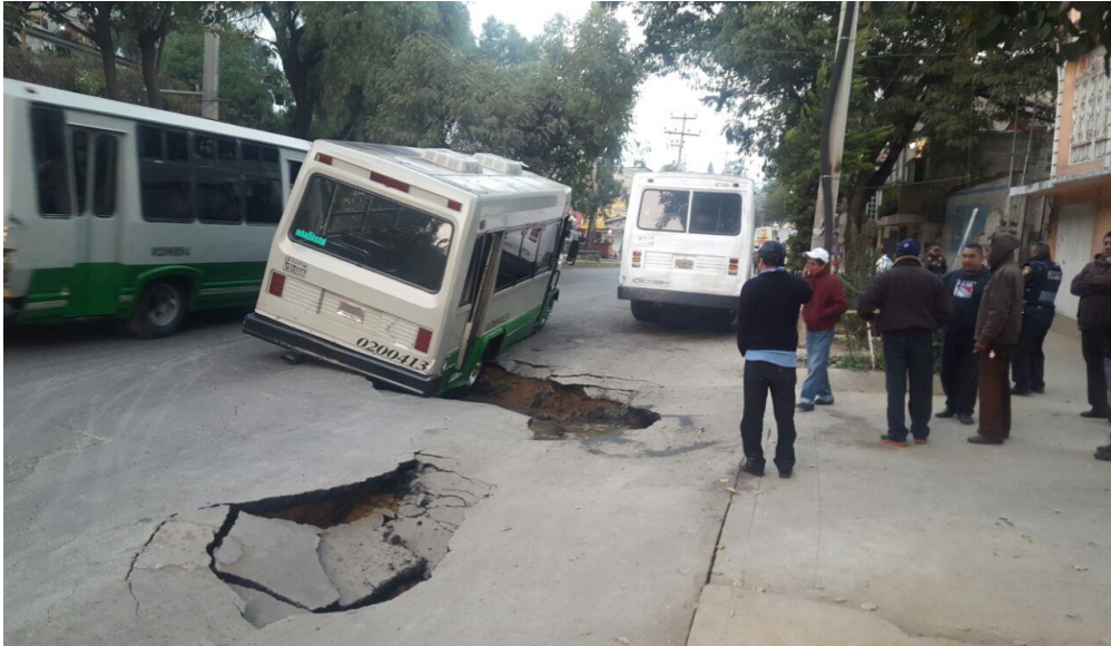
Figura 11. Hundimientos en la carretera Tulyehualco – México. Tomada de: Informativo Anáhuac. Por Daniel Flores. Enero 17, 2017
