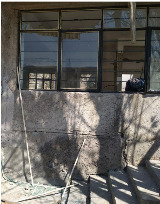
Fotografía 44. Fractura en la pared de la fachada de la casa.
