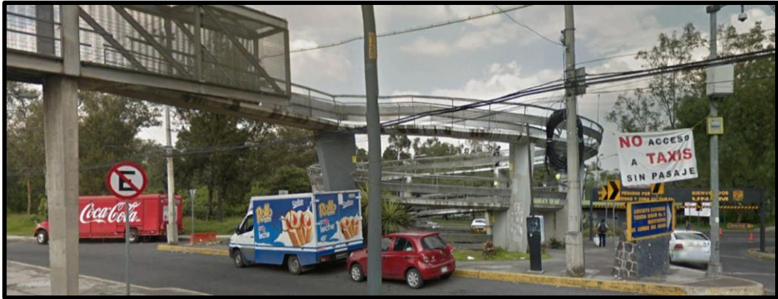
Figura 4.5: Estacionamiento de Proveedores en el caracol del Metrobús, Google earth (2018)
