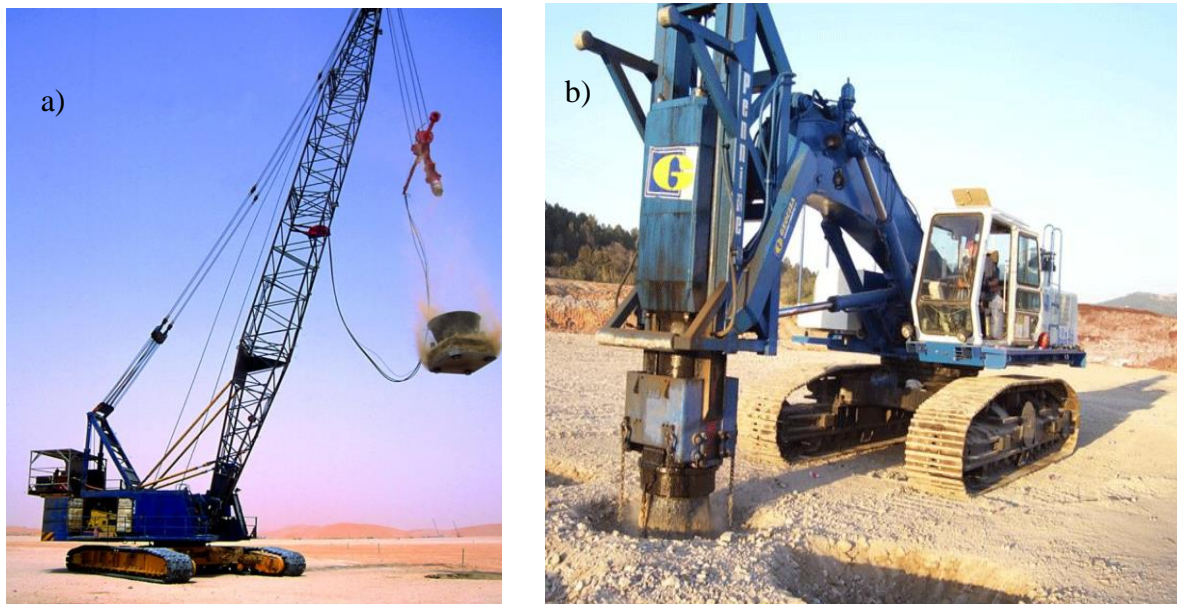
Figura 7.2 a) Método de compactación dinámica estándar (Grupo Menard) y b) Método de compactación dinámica (grupo Ferrara)
