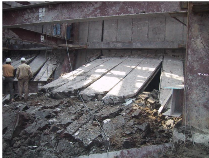
Figura 5.1. Tabletillas de concreto de 1.0m de ancho y 0.3m de espesor, desplantadas a 13.5m de profundidad; al centro se observan los pies de las tabletas prefabricadas de concreto reforzado; se aprecian también las columnas y traveses de los sótanos que constituyen el sistema de retención (Cuevas, 2012).
