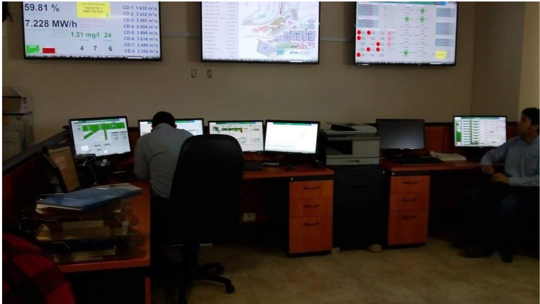
Figura A-18. Monitoreo en PTAR Atotonilco de Tula.
