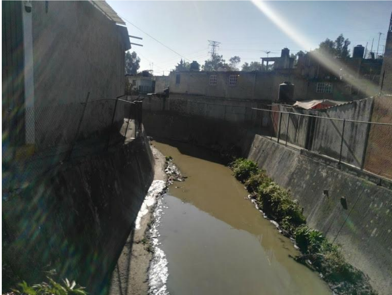
Figura A-7. Canal de agua residual en el municipio de Tlalnepantla.
