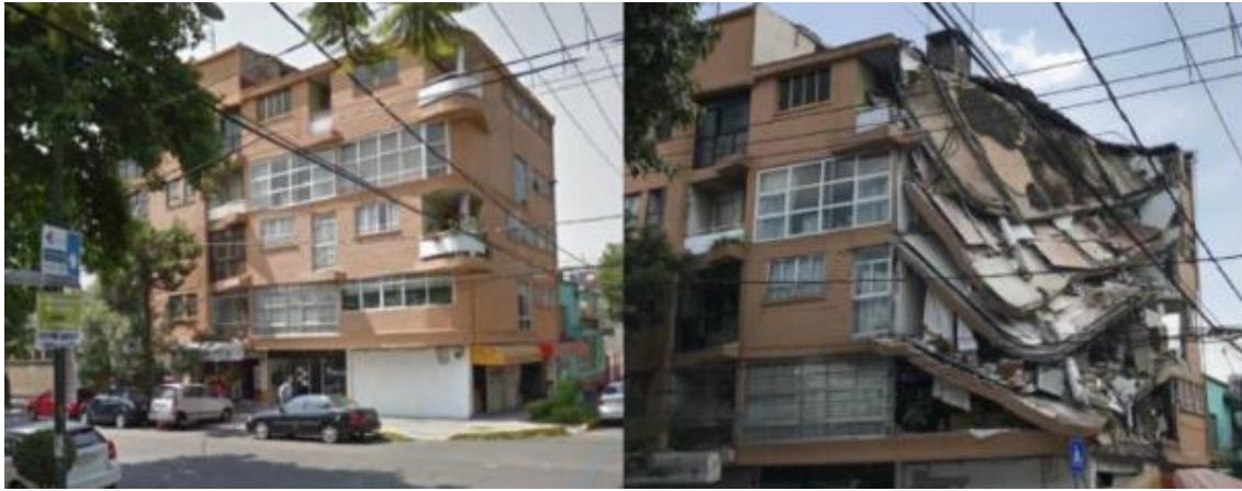
Fig. 1.3 Departamentos Col Del Valle, Sismo de 2017, Ciudad de México.
